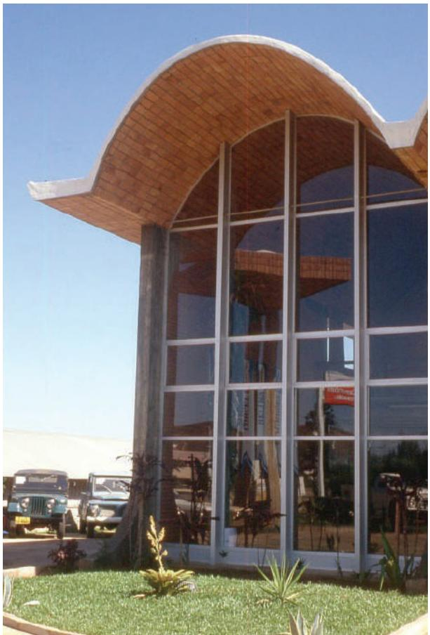
**Fig. IV-79.** Vista externa com aba final para esforços horizontais. Veja reflexo da caixa d'água. (\*-5).
