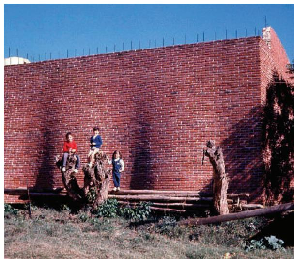
**Fig. XII-97.** Em obra, as paredes prontas com duplo tijolo e armaduras guias no meio das mesmas que sobressaem na espera do telhado. (\*-5).
