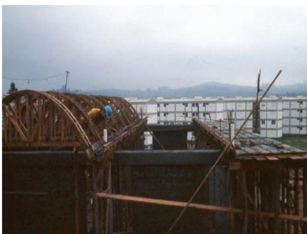
**Fig. III-110.** Montagem com avanço lateral perto da aba horizontal final. (\*-5).
