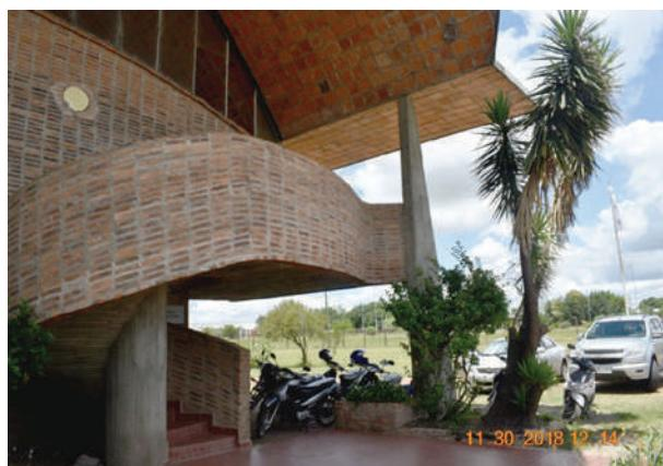
**Fig. I-100.** O pilar central da escada e a parede de tijolo armado que serve de guarda corpo sustentam a laje da escada. (\*-5).
