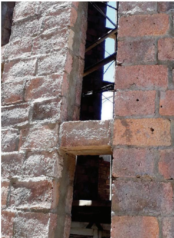
**Fig. I-107.** Detalhe da pilastra da torre e sua trava. (\*-5).
