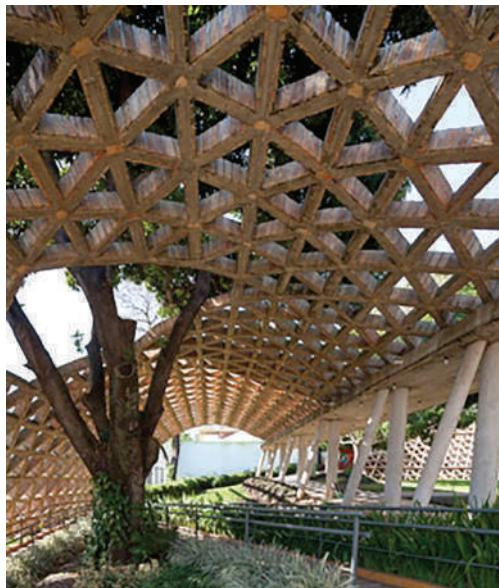
**Fig. X-42.** Neste caso, uma abóboda vazada feita com elementos lineares curvos de tijolo armado. (\*-15).
