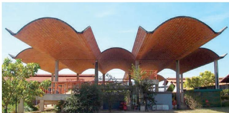
**Fig. X-28.** Vista frontal das coberturas das passarelas, percebe-se uma sensação de leveza estrutural em cerâmica armada. (\*-12).
