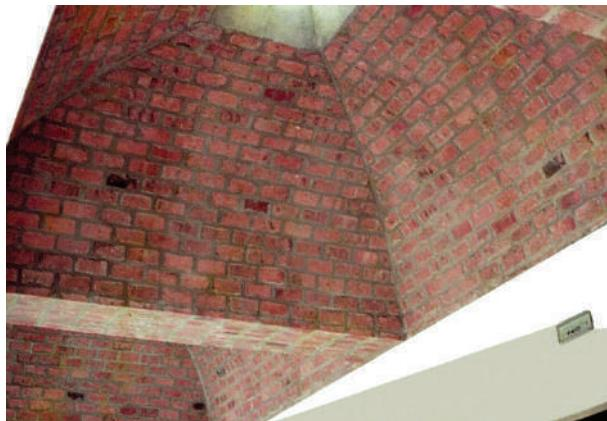
**Fig. XI-58.** Cúpula autoportante em “recanto de claustro”, com lanternim superior. (\*-5).
