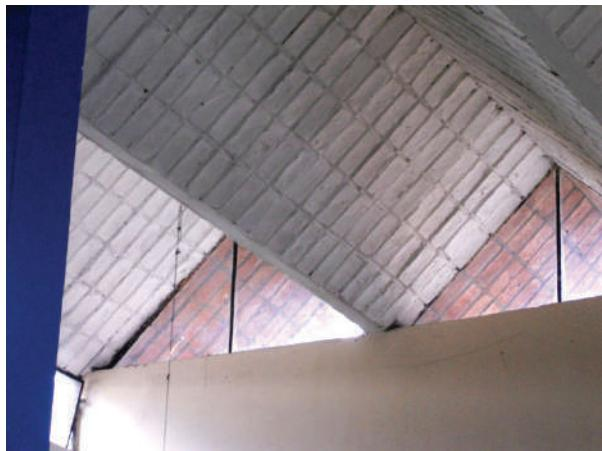
**Fig. VII-20.** O vidro fixo do triângulo vai na junta entre tijolos e num ferro **T** de 1" vertical no meio. (\*-5).
