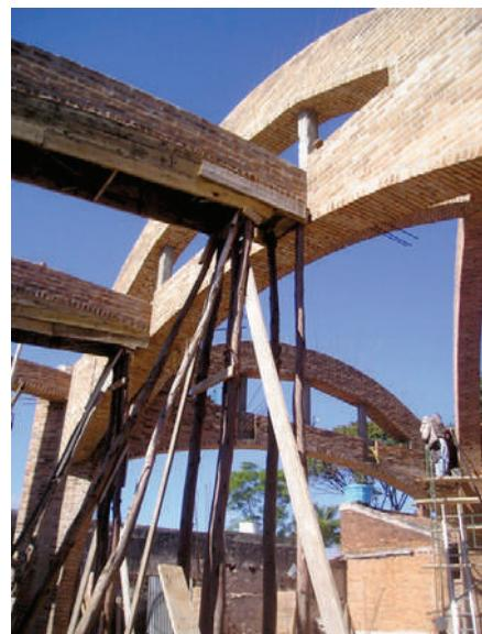
**Fig. VIII-53.** Os semiarcos "arc boutante" na junção com a viga-arco. (\*-5).
