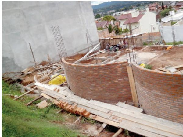
**Fig. IX-6.** Forma pronta para preencher o concreto do pilar. (\*-5).
