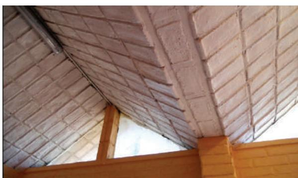
**Fig. VII-44.** Vista do vale com tijolo à vista. Vidro fixo superior com montante de tijolo, a baquete direto no tijolo. (\*-5).
