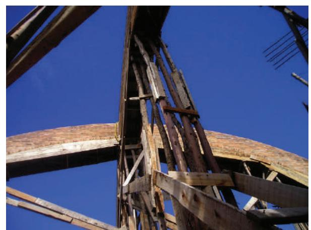
**Figs. VIII-48 e VIII-49.** Cambotas dos arcos centrais, estes estão feitos em tijolo armado. (\*-5).
