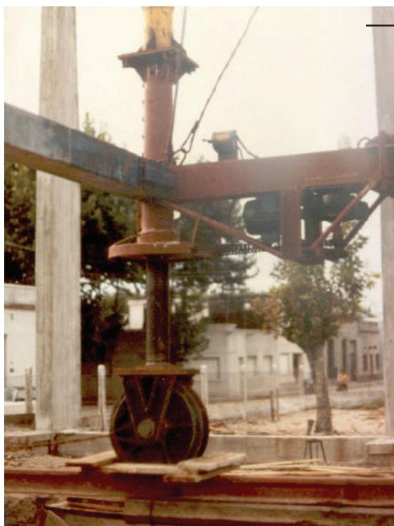
**Fig. I-45.** Detalhe do mecanismo de descida e elevação dos andaimes interconectados eletricamente, esses pontos se movimentam iguais e conjuntamente. (\*-3).
