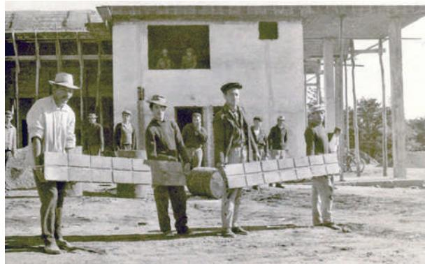
**Fig. III-24.** Com 7 tijolos de campo maciços para a usina de processamento de leite Conaprole, Rivera – UY (1966). Comprimento do pré-moldado 1,75 m. (\*-5).
