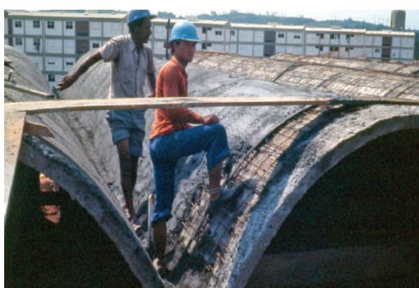
**Fig. III-114.** Capeamento final sobre armadura com gabarito de espessura. (\*-5).
