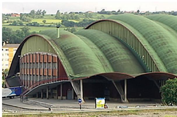
**Fig. XI-3.** Vista do acesso e dos triângulos dos contrafortes de concreto. (\*-13).
