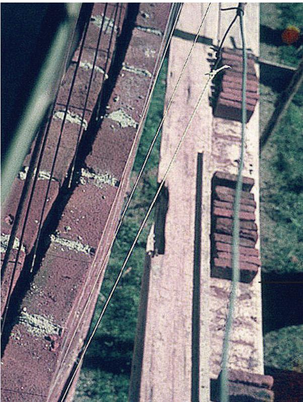
**Fig. XII-100.** Vemos como se gera a parede e quem guia são as armaduras. (\*-5).
