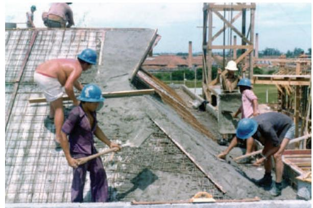
**Fig. XI-52.** A cobertura já foi completada com os pré-moldados e já colocadas as armaduras e, agora, estão pondo 3 cm. de concreto. (\*-5).
