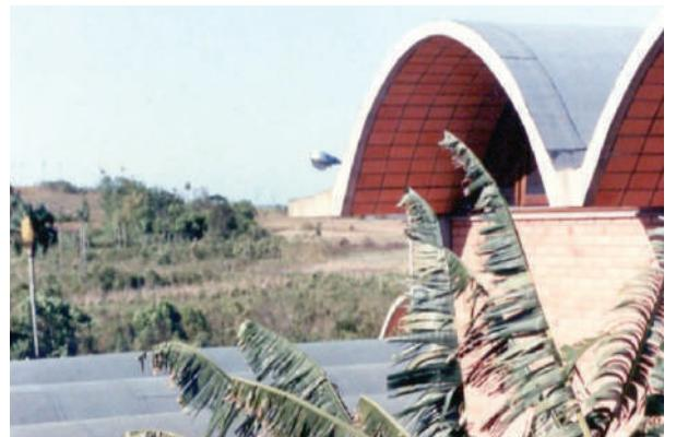
**Fig. III-90.** Neste caso, a abóboda foi impermeabilizada com manta asfáltica e acabamento de alumínio gofré. (\*-5).
