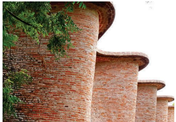
**Fig. XII-19.** Viga ondulante de coroamento. (\*-5).
