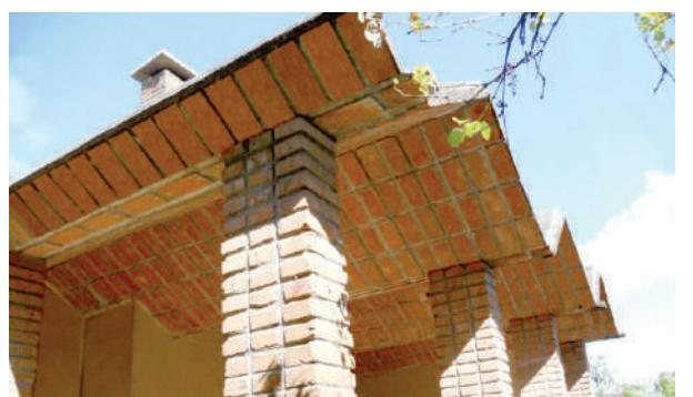
**Fig. VII-45.** Barbacoa, cobertura e pilares de tijolo armado. (\*-5).
