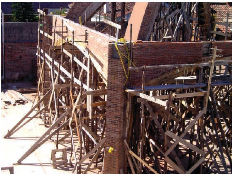
**Fig. VIII-52.** Viga-arco-cinta em tijolo armado. (\*-5).
