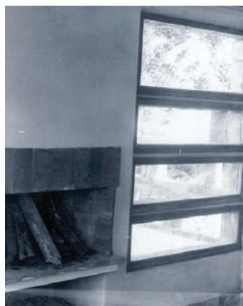
**Fig. VII-30.** Quando os vidros são fixos as divisões são de tijolo. (\*-5).
