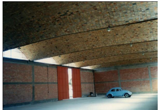
**Fig. XI-32.** A altura mínima do depósito é de 6 m.. A viga superior de coroamento em toda a volta serve também de tensor. (\*-5).
