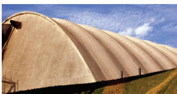
**Fig. I-130.** Vista externa de graneleiro feito em tijolo armado (1982). (\*-4.3).
