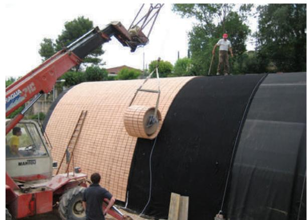
**Fig. X-55.** Uma montagem rápida do *Flexbrick* sobre a forma curva. (\*-16).
