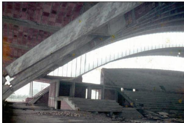
**Fig. XI-18.** Vista do contrafrente e a articulação feita com 7 Ø de 60 mm. O vão na corda do arco entre duas articulações é de 96 m. e entre as bases dos contrafortes é de 100 m. (\*-5).
