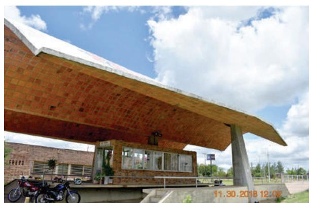
**Fig. I-73.** São impressionantes os balanços. Isto implica um grande engastamento da cobertura no extremo do pilar. (\*-5).
