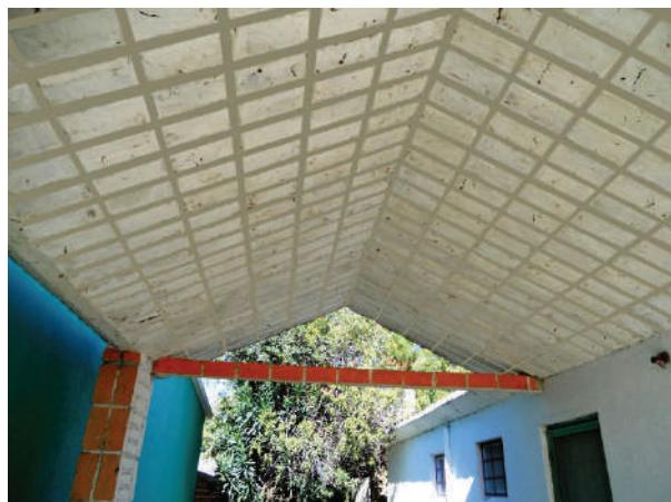
**Fig. VII-36.** Viga de tijolo faz de tensor. (\*-5).
