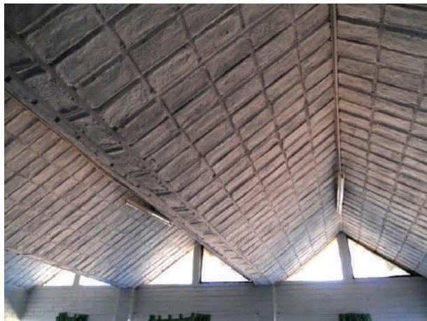
**Fig. III-19.** O pré-moldado usado pesou cerca de 20 kg e tinha 1,25 m. de comprimento. Foi usado para a cobertura do Liceo de Vichadero - Uruguai, em 1964. Cobertura plissada. (\*-5).
