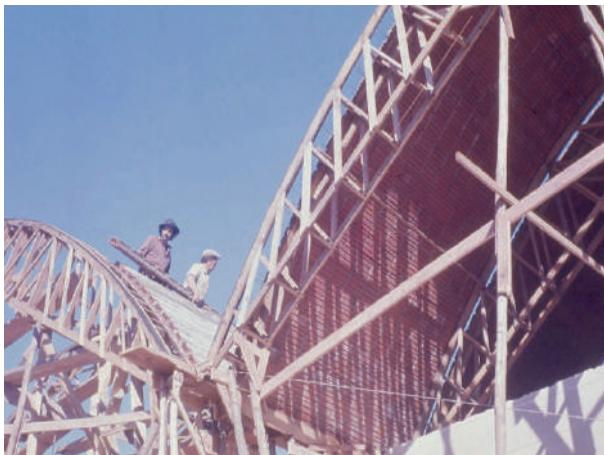
**Fig. III-74.** Colocação dos pré-moldados. A montagem se faz com dois operários e o peso do pré-moldado deve ser leve, inferior a 50 kg. (\*-5).
