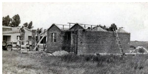
**2 Figs. VII-38.** Mostrando a montagem do telhado. Somente se coloca uma tábua guia na parte superior, pois a parte debaixo do pré-moldado apoia-se na parede. (\*-5).
