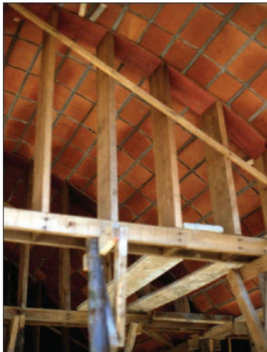
**Fig. III-99.** Cambota simples. Pode ver-se a singeleza da cambota. (\*-5).
