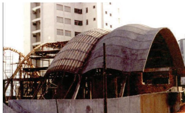
**Fig. IV-53.** Continuando a obra, foram colocados os pré-moldados nos 2 módulos e na aba, depois foram colocadas as armaduras e feito o capeamento de um módulo e a aba. Isto permitiu a retirada das cambotas da primeira fatia e as escoras, e recolocá-las num novo módulo para seguir avançando na cobertura. (\*-5).
