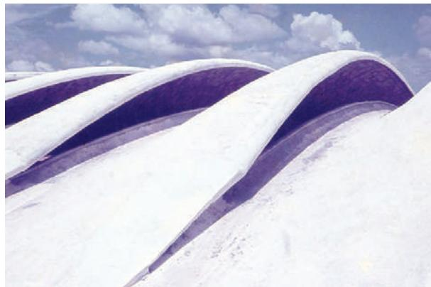
**Fig. I-48.** Vista externa da cobertura, observa-se o traspasse das fatias da cobertura. Feita a cobertura, impermeabiliza-se com tinta branca imediatamente. (\*-5).
