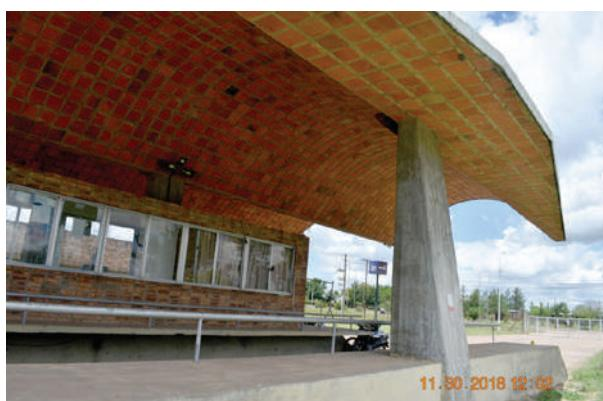
**Fig. I-72.** Pilares reforçados e vigas baldrames para suportar os esforços horizontais e evitar os tensores na passagem dos caminhões. (\*-5).
