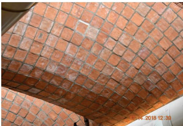
**Fig. XII-55.** Detalhe da cobertura da circulação central, se fez como uma forma só, que dia a dia se desloca. (\*-5).
