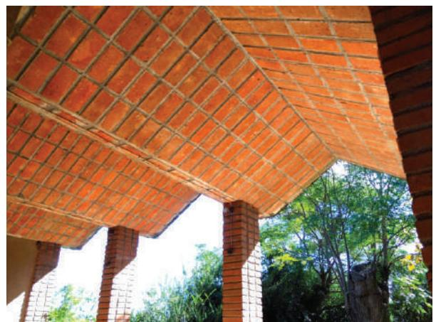
**Fig. VII-7.** Vista interior da Biblioteca Municipal de Rivera – Uruguai (1966). A transferência das cargas se dá na parede sobre uma cinta calha ou sobre uma viga transversal. Arq. Alberto Brizolara. (\*-5).
