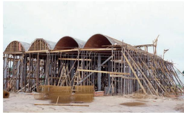
**Fig. III-104.** Exemplo de escoramento inclinado. (\*-5).
