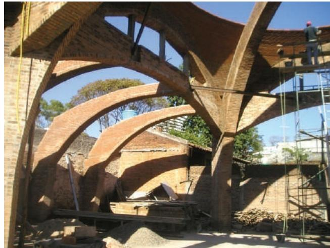
**Fig. VIII-42.** A cúpula passa por cima dos arcos diagonais, mas muito próximo. (\*-5).
