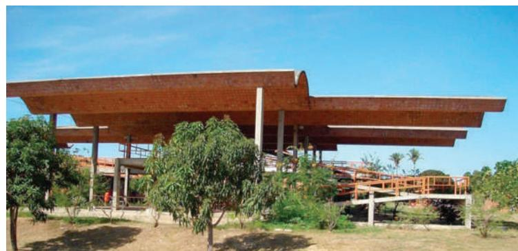
**Fig. X-29.** Vista lateral da cobertura em cerâmica armada. Observe o balanço de 12 m.. (\*-12).
