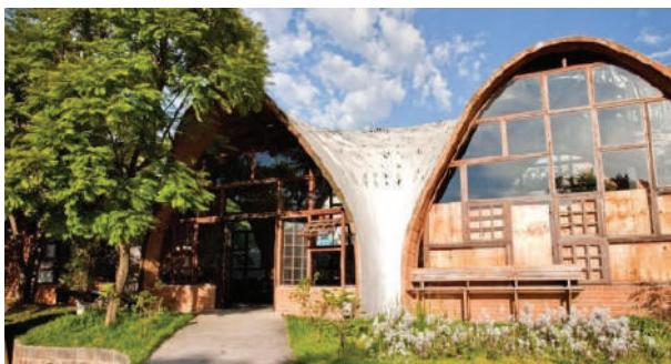
**Fig. X-33.** As abóbodas são nervuradas, e nota-se por cima a necessidade dos vitrais. (\*-13).
