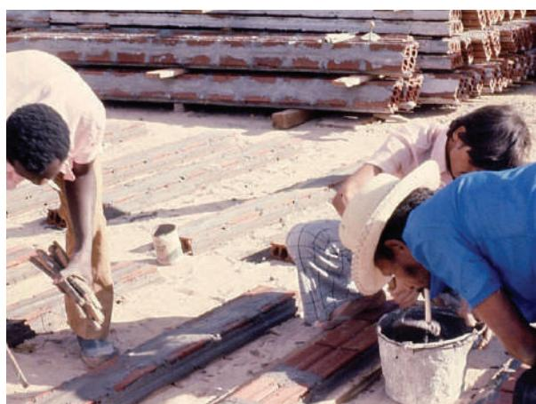
**Fig. III-43.** Pré-moldado com 12 tijolos especiais A=205, E= 104, comp.=2,85 m. Estocagem ao fundo na foto. (\*-5).
