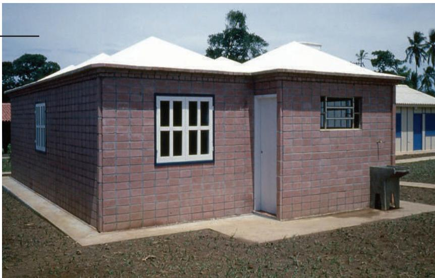
**Fig. XI-61.** Casa popular com telhado em ponta de diamante em tijolo armado protótipo do concurso. Os beirais se parecem aos antigos “beirais de cachorro”. (\*-5).
