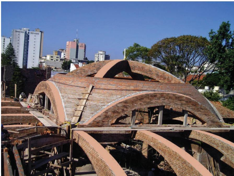
**Fig. VIII-45.** Anel de armadura em colocação na cúpula. Com estas armaduras, absorvem-se os empuxos horizontais que começam a ter a construção da cúpula. (\*-5).
