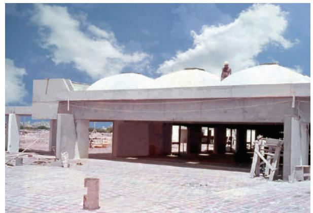
**Fig. XI-59.** Vista externa. Operário fazendo a impermeabilização. (\*-5).
