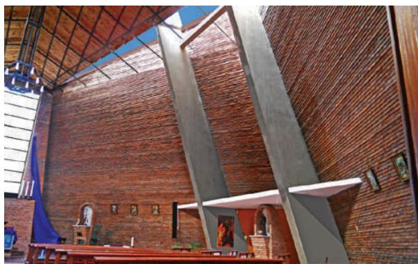
**Fig. XII-92.** Vista lateral do interior. Vemos a inclinação para dentro das paredes e seus tijolos escalonados. (\*-5).
