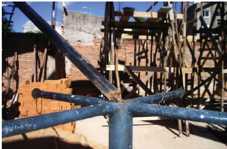
**Fig. VIII-40.** Centro de curvatura dos elementos estruturais do quadrado central. Após a marcação da obra, este foi o primeiro elemento a ser posto para guiar a construção. Está elevado do piso a 1,50 m.. Observe o extremo do cintel metálico apoiado no centro da cúpula. (\*-5).
