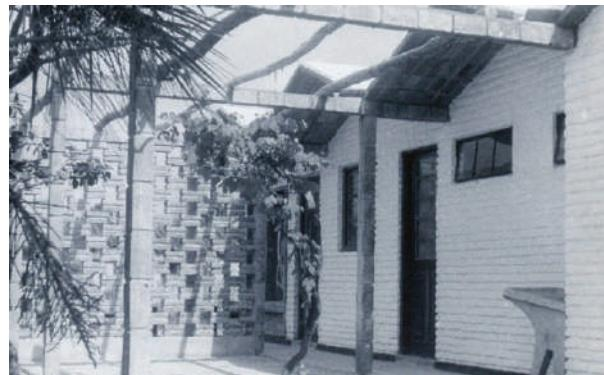
**Fig. XI-74.** Pátio com pergolado e coluna de tijolo armado. (\*-5).
