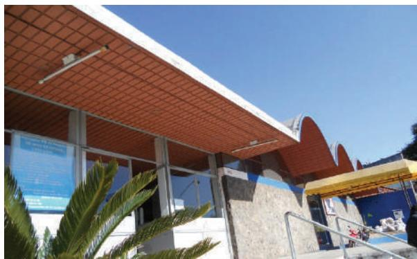
**Fig. IV-66.** Entrada ao conjunto com laje, plana de tijolo armado. Ao fundo, salão de festa com abóboda reta autoportante. (\*-5).
