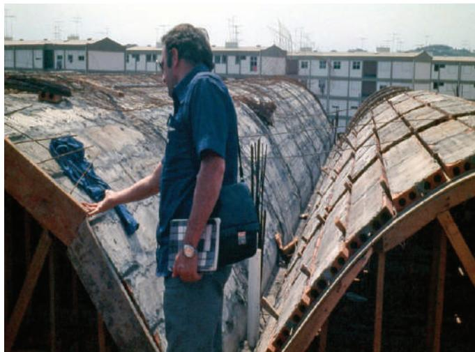
**Fig. III-100.** O autor inspecionando a obra. Observa-se que a junta dos pré-moldados na abóboda da esquerda está preenchida; na da direita, ainda não. (\*-5).
