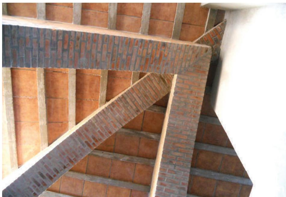
**Fig. VIII-65.** Igual a figura anterior, vista de baixo para cima onde se observa a abóboda industrializada. (\*-5).
