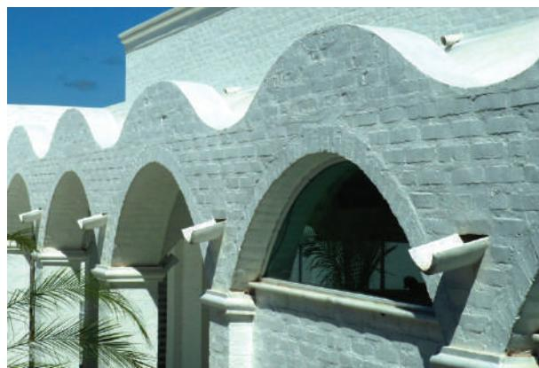
**Fig. VIII-77.** Detalhe das gárgulas para a expulsão da água. (\*-5).
