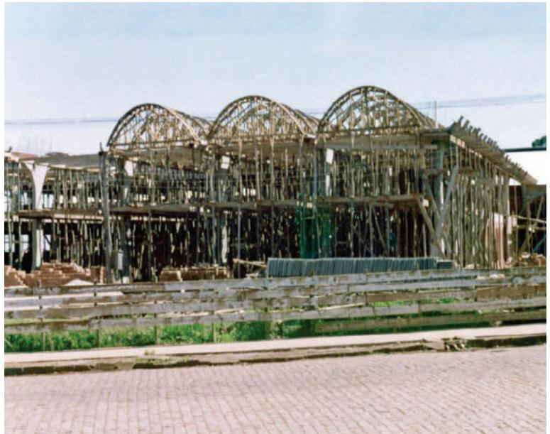
**Fig. III-63.** Dada à simplicidade das cambotas feitas com sobrante de madeira, fazem-se muitas para dar rapidez à obra. Este exemplo, 2000 m<sup>2</sup>, feito (montado e terminado) em 1 mês e 1 semana. (\*-5).
