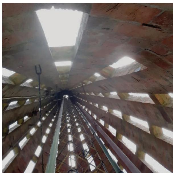
**Fig. I-113.** Interior da torre onde se observam os canos, a escada e a passagem através da caixa d'água. (\*-5).
