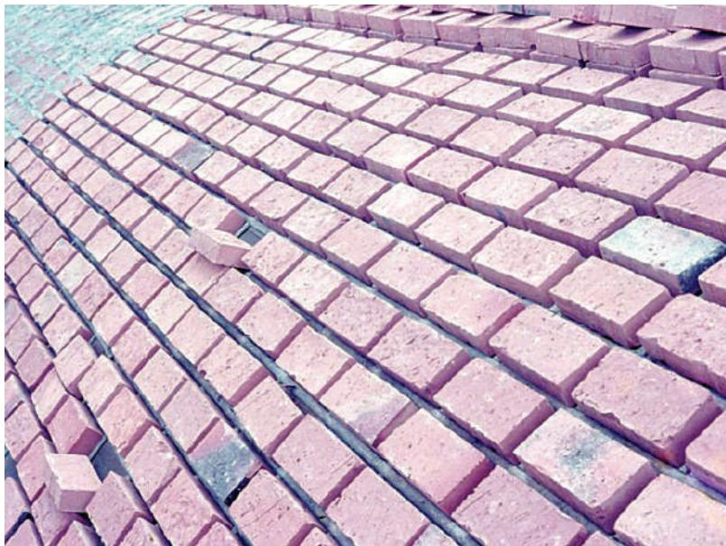
**Fig. I-17.** Os tijolos são colocados nos lugares entre as molduras das juntas. Ainda não foram colocadas as armaduras nem a argamassa de cimento. (\*-5).
