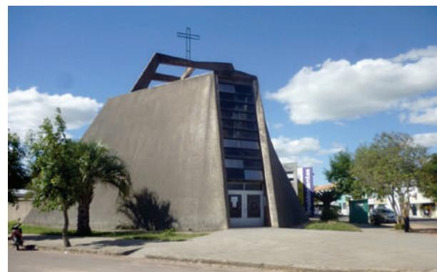
**Fig. XII-93.** Vista externa, onde se observam as paredes retorcidas (parabolóides hiperbólicos). Sem autorização e sem uma solução contra a fuligem, o reboco externo prejudicou a estética. (\*-5).
