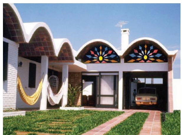
**Fig. IV-12.** Vista do acesso à casa. Nas abóbadas frontais, o concreto pré-moldado dos vitrais foi feito em 4 partes; nas abóbadas laterais foi feito em 2 partes. (\*-5).
