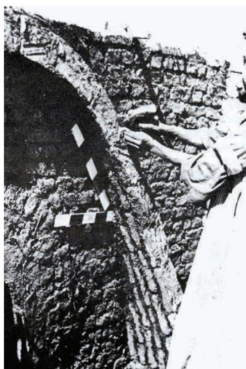
**Fig. X-18.** Vista da fiada completa com o triângulo de abóboda junto à parede e ao gabarito que verifica a inclinação adequada. (\*-11).
