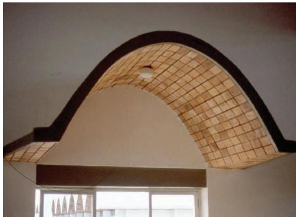
**Fig. IV-89.** Nos acessos às abóbodas têm duplo balanço de 2.3 m. referente à parede. (\*-5).
