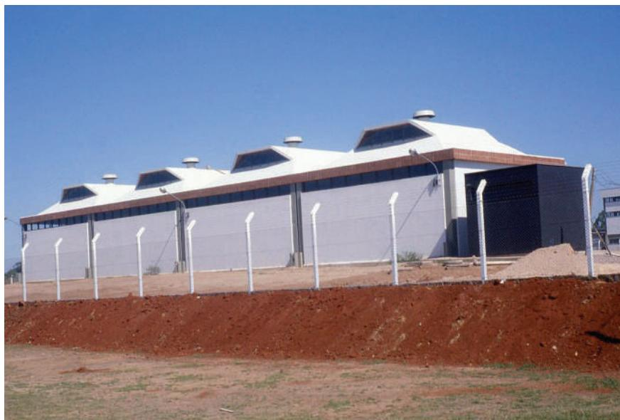
**Fig. XI-46.** Fábrica Memphis vista externa com a cobertura em tronco de pirâmide. (\*-5).
