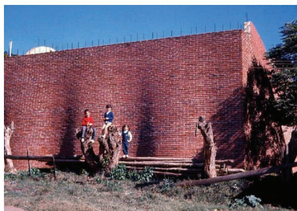
**Fig. IV-35.** As paredes têm base senoidal, sendo retas na parte de cima. São paredes duplas de meio tijolo à vista. Entre as duas fica um espaço de 4 cm. com armadura vertical que se preenche com argamassa de cimento. Estas paredes da foto ficaram 14 anos com a obra paralisada. Quando se continuou a obra estes meninos tinham ao redor de 20 anos. (\*-5).
