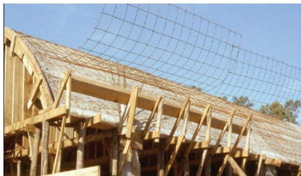
**Fig. III-112.** Tela eletrosoldada sobre cobertura ( $15 \times 15 -\varnothing 3.5 \text{ mm}$ ). (\*-5).
