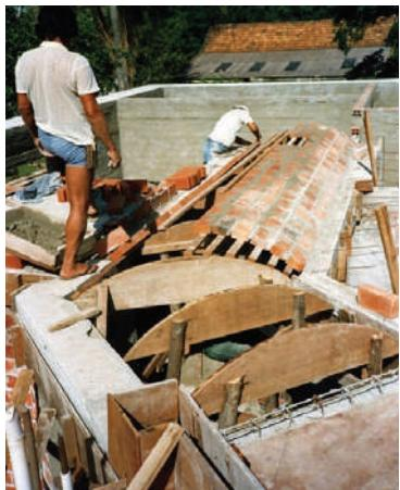
**Fig. V-45.** Nos encontros de abóbadas em ângulos haverá recorte de tijolo, se bem coordenados fica muito bom. (\*-5).
