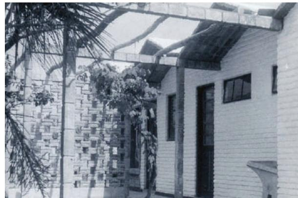
**Fig. VII-29.** Pátio com pérgola e coluna de tijolo armado. (\*-5).
