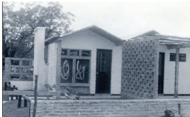
**Fig. XI-73.** Cobertura com pré-moldado de tijolo mais 2.5 cm. de argamassa e pintura. (\*-5).
