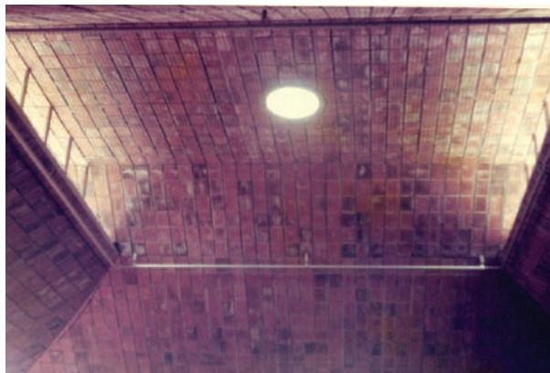
**Fig. XI-51.** Vista interior, observe que o tijolo é especial para ter pré-moldados de 3 m.. (\*-5).
