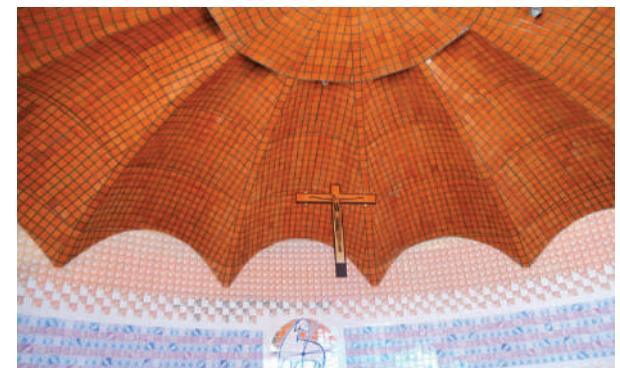
**Fig. IV-48.** Cobertura com abóbodas em dupla curvatura afunilada. (\*-5).
