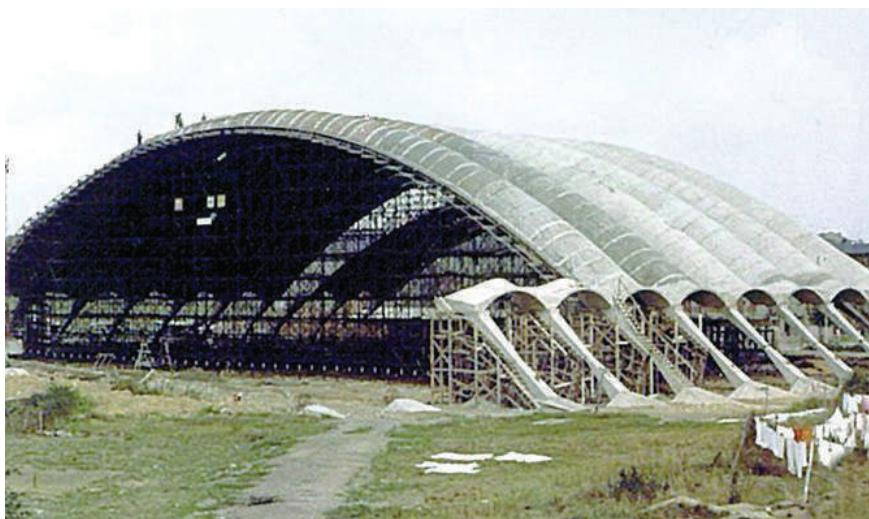
**Fig. XI-15.** Para fazer a montagem, primeiro deixam-se prontos e escorados os contrafortes, as articulações e os cabeçalhos que unem estes elementos. (\*-13).
