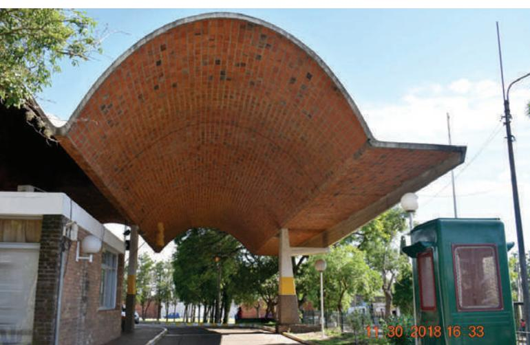
**Fig. I-81.** Antiga Estação Rodoviária de Salto – UY. (1974). A laje de borda com viga pré-tensada apoia no braço do pilar. (\*-5).
