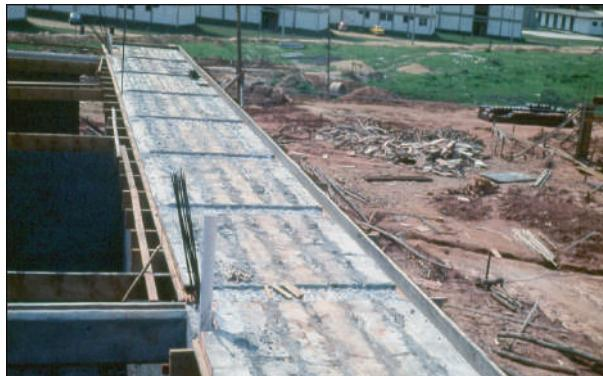
**Fig. III-113.** Laje horizontal no extremo da última calha, pronta para serem colocadas as armaduras. (\*-5).
