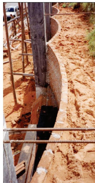
**Fig. IX-13.** Vista no outro sentido. O muro de arrimo recém-começado. Os tijolos são assentes em argamassa de cimento. O enchimento é uma areia argilosa. (\*-5).
