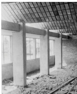
**Fig. VII-42.** Cobertura autoportante vista interior, em construção. (\*-5).
