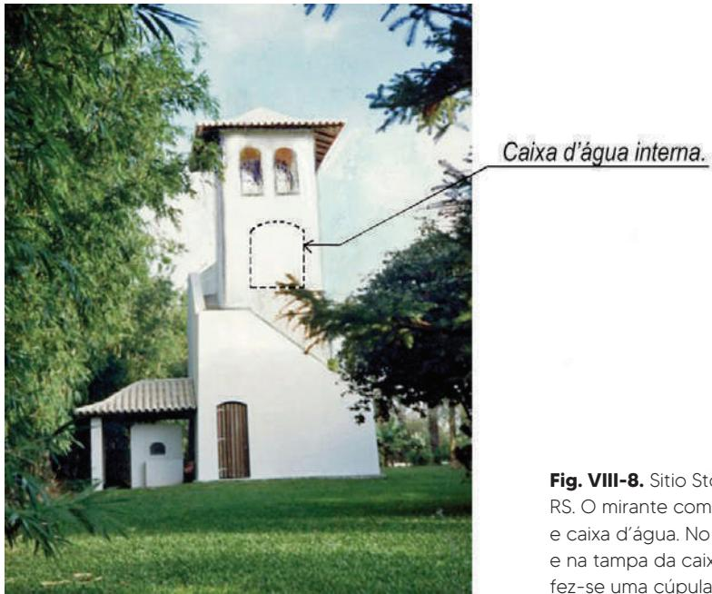
**Fig. VIII-8.** Sitio Sto. Antônio – Viamão/RS. O mirante com adega, churrasqueira e caixa d’água. No forro do mirante e na tampa da caixa d’água, fez-se uma cúpula de tijolo. (\*-5).
