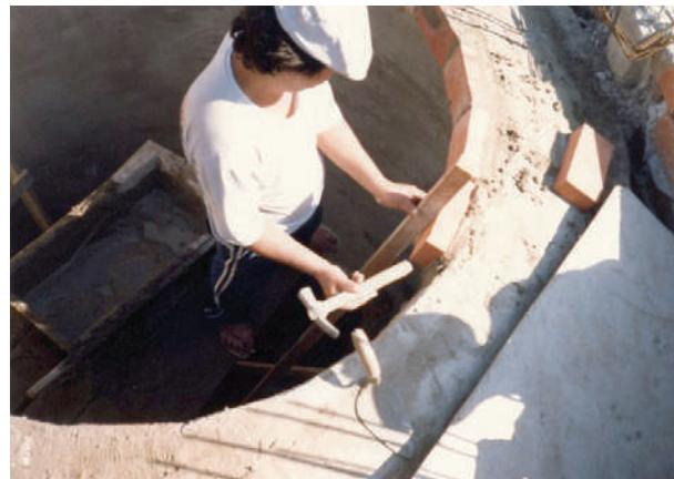
**Fig. VIII-12.** O pedreiro ajusta com o martelo a posição do tijolo. (\*-5).
