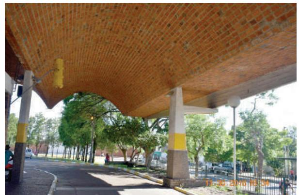
**Figs. I-87 e I-88.** Observe nas imagens que a laje-viga horizontal está apoiada na abóboda de um lado e na viga lateral do outro lado. Esta viga é protendida, com duplo balanço e seu apoio é uma mísula que sai do pilar. (\*-5).
