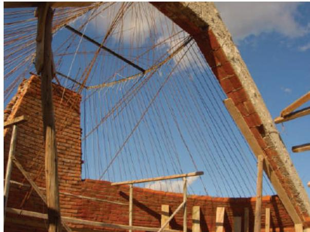
**Fig. XII-2.** As armaduras apresentadas, mas ainda não esticadas e seguradas na posição. (\*-5).
