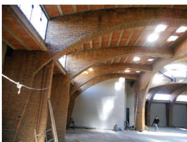
**Fig. VI-40.** Detalhe da iluminação e abóboda industrializada. (\*-5).
