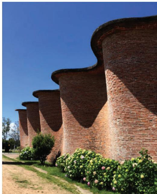
**Fig. IX-33.** Vista lateral, junção entre paredes e cobertura de dupla curvatura com viga horizontal senoidal. (\*-7).
