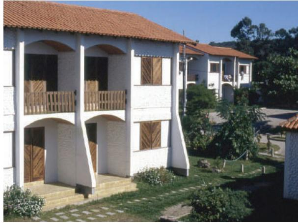
**Figs. V-6 e V-7.** O conjunto do apart-hotel é de 2 (dois) pavimentos, poderia ser de mais pavimentos. Neste caso, a abóboda de baixo substitui e dá o acabamento do que seria a laje de entrepiso. A abóboda de cima é forro, e sobre ela vai o telhado com telha de barro. (\*-5).
