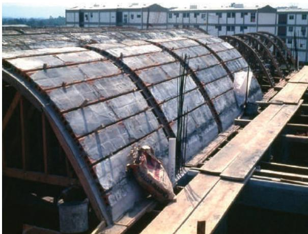
**Fig. III-85.** Exemplo de avanço lateral, as anteriores já têm armaduras. (\*-5).
