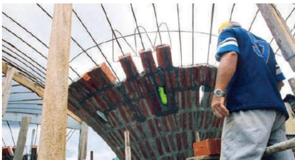
**Fig. X-31.** Veja armação especial com vergalhões empareados e tijolos segurados provisoriamente com grampos de ferro. (\*-13).
