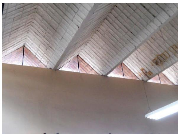
**Fig. VII-22.** O plissado apoia diretamente sobre a cinta calha da parede. (\*-5).
