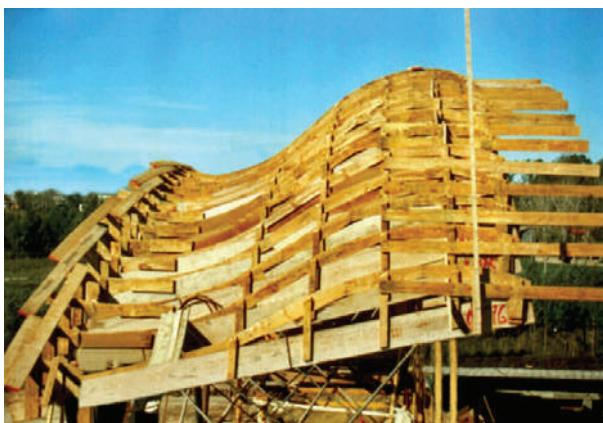
**Fig. I-39.** Fazer a forma em dupla curvatura em grandes dimensões é uma operação artesanal, feita por operários capacitados. (\*-5).
