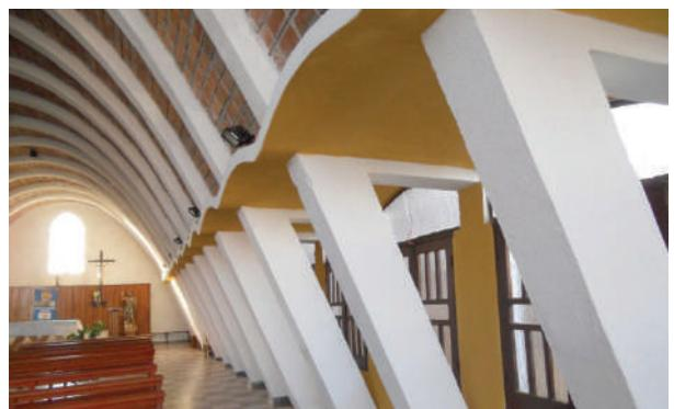
**Fig. IV-26.** Galeria lateral com pré-moldados curvos (\*-5).
