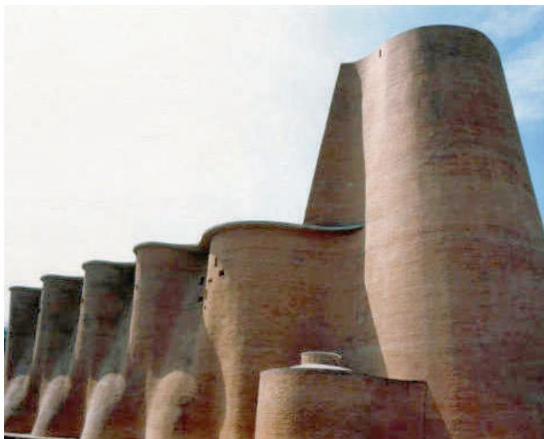
**Fig. XII-46.** Igreja São João de Ávila, vista do lado posterior. Em primeiro plano, a torre do altar; à continuação, a parede lateral em dupla senoide, tudo com a tecnologia de "paredes duplas com armaduras guias". (\*-2).
