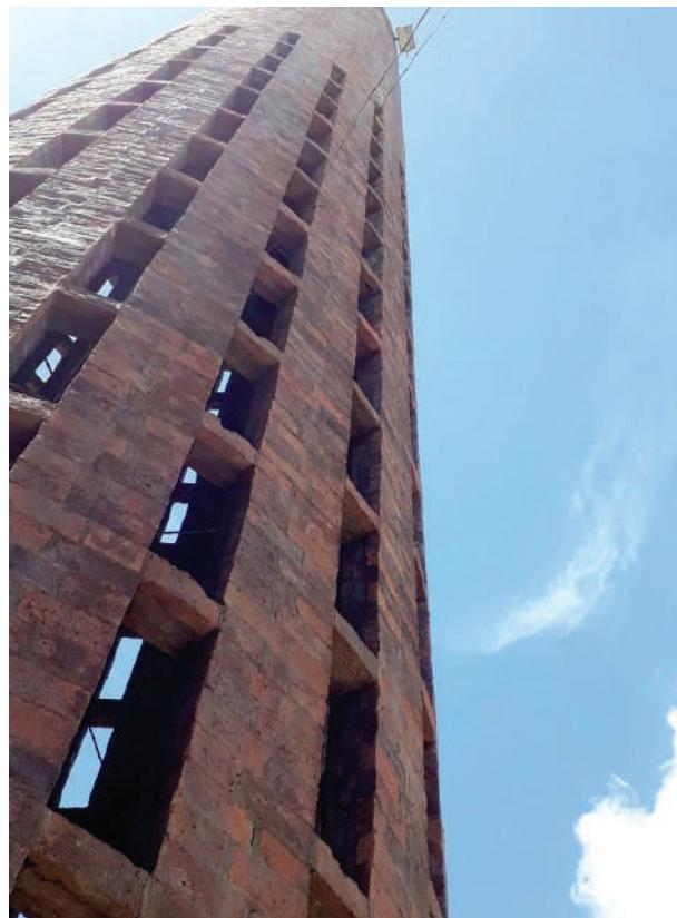
**Fig. I-111.** Detalhe da torre e seu travamento. (\*-5).
