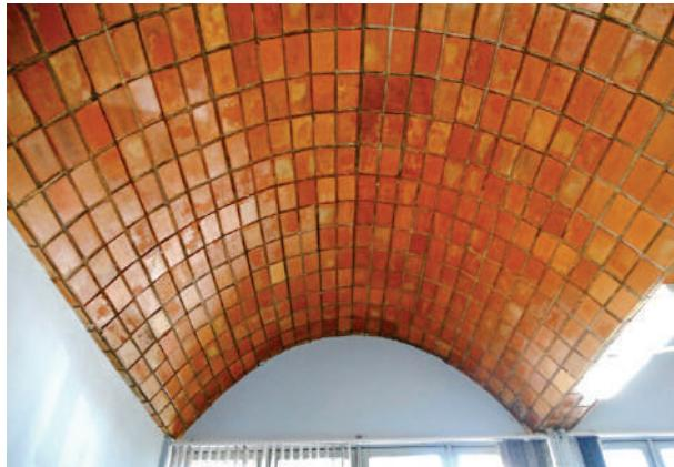
**Fig. I-22.** Neste exemplo, a forma foi sarrafeada marcando a posição dos tijolos, nota-se que, posteriormente, os tijolos foram envernizados. (\*-5).
