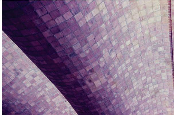
**Fig. I-49.** A diferença de alturas das fatias permite a entrada da luz distribuída. À direita na foto, vê-se a ranhura para colocar o vidro fixo da esquadria. (\*-5).
