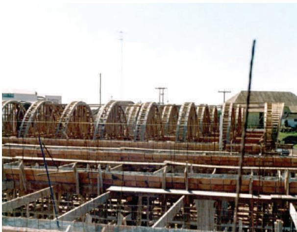
**Fig. III-64.** Nesta figura, a cambota extrema é especial e as outras são chamadas de “cambotas separadas” (Fig. III-50). (\*-5).
