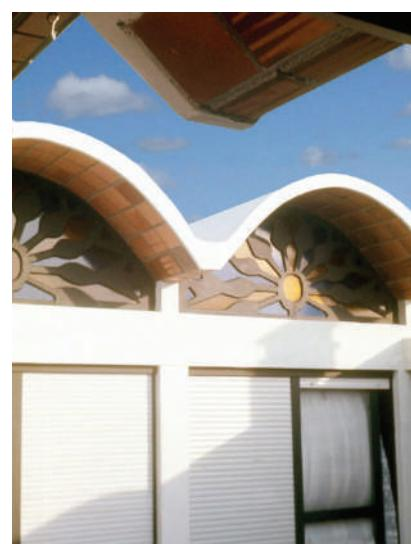
**2 Figs. IV-9.** Detalhes dos vitrais pré-moldados em concreto e vidro. (\*-5).
