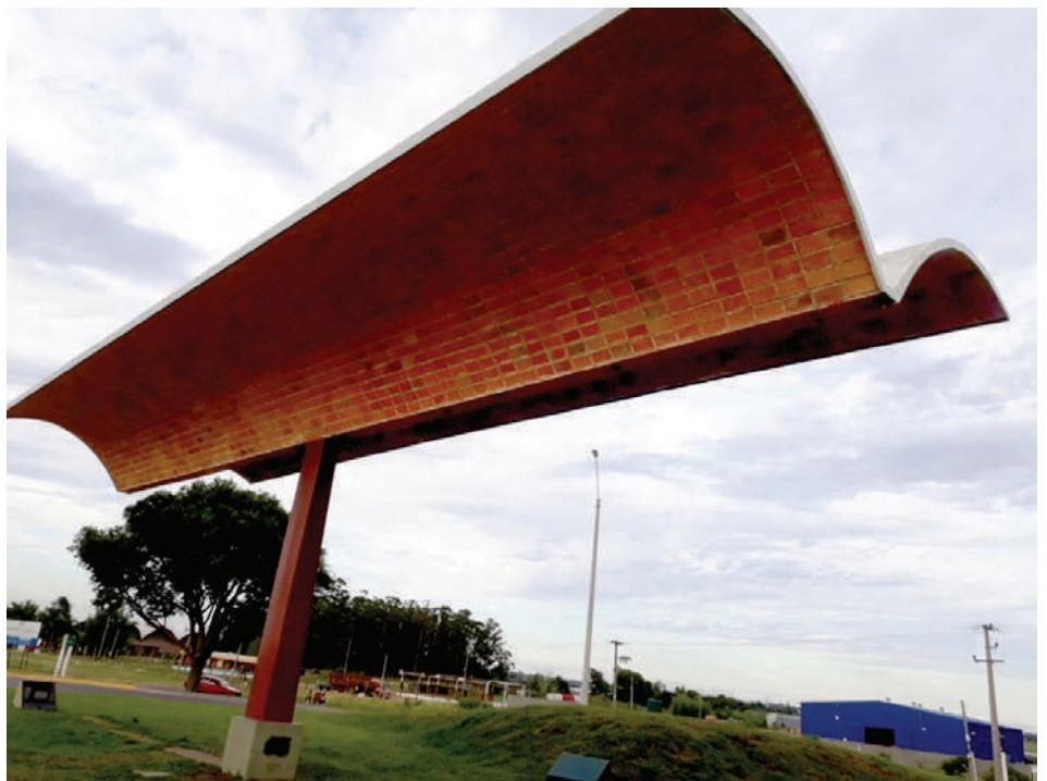
**Fig. I-3.** Esta gaivota desafia as leis da gravidade e da estática. Qual será a sua deformada?, veremos mais adiante. Está submetida, além dos esforços normais, a esforços de tombamento por ventos e cargas assimétricas. Também deve suportar esforços de torsão no pilar. (\*- 5).
