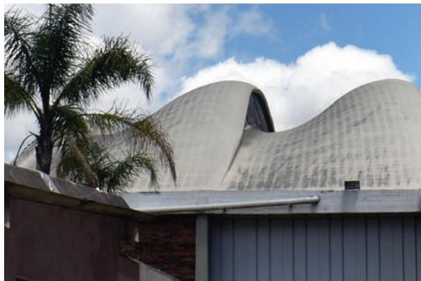
**Fig. I-47.** Nota-se que em cada cobertura, segundo a necessidade, o perfil da curva pode mudar. Depois de anos, temos de cuidar quanto à proteção da impermeabilização, pois a lámina de concreto é muito fina (3 cm.) e pode afetar as armaduras. (\*-5).
