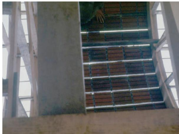
**Fig. III-75.** Junta em obra. Entre os pré-moldados colocados fica uma separação que deve ser preenchida (\*-5).
