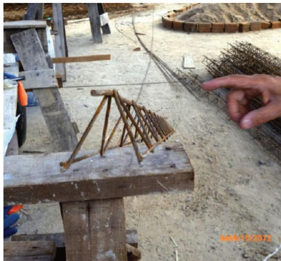
**Fig. VI-19.** As treliças são eletrosoldadas, compradas da siderúrgica. (\*-5).
