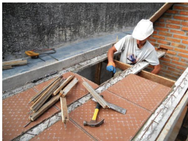
**Fig. VI-31.** Colocando e assentando as placas que ficarão à vista por baixo. Observe os sarrafos com molduras feitas de ferro de obra. (\*-5).
