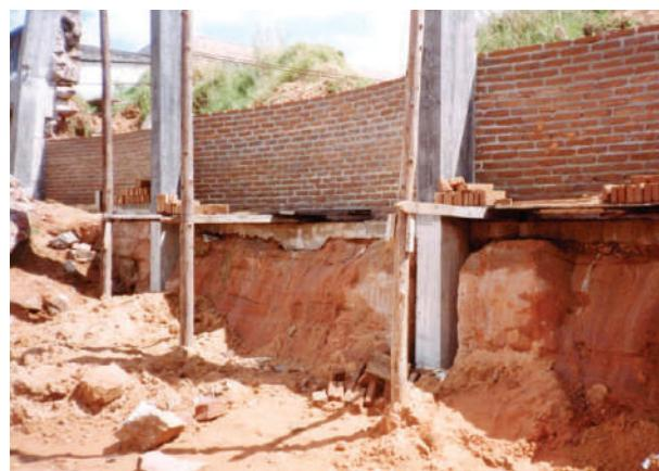
**Fig. IX-18.** Começo do muro sobre laje, sobre rocha arenita. A base do pilar está dentro da rocha cortada para ter a reação ao empuxo. (\*-5).
