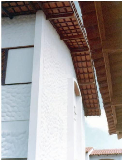
**Fig. V-11.** Fotos dos extremos dos blocos do apart-hotel onde se mostra que não é necessária uma aba horizontal para absorver os empuxos. Foi feita a solução do detalhe da figura anterior. (\*-5).
