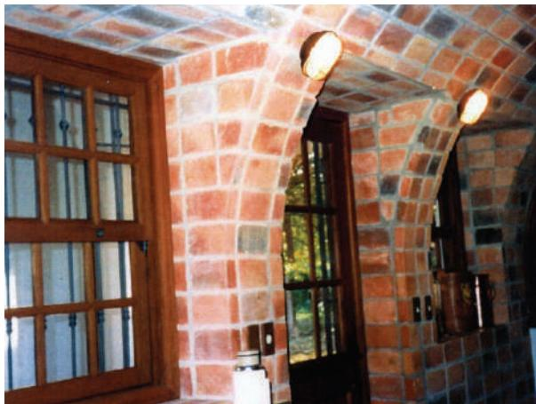
**Fig. V-44.** Nas paredes laterais tudo é feito com tijolo de espelho. (\*-5).
