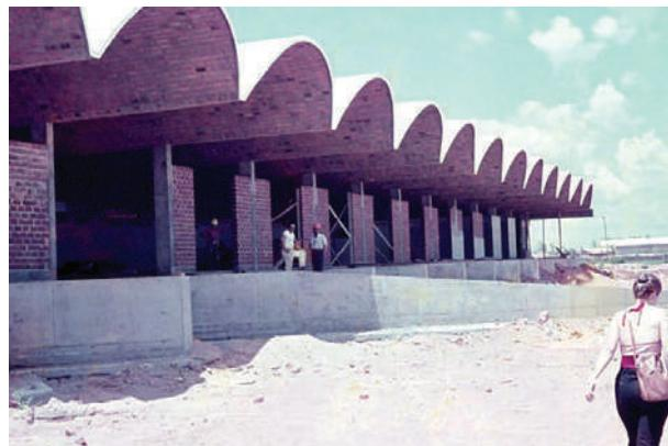
**Fig. I-12.** Conjunto de abóbadas no extremo e sem tensor. (\*- 5).
