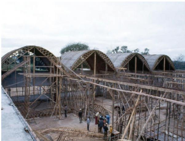
**Fig. III-108.** Avanço frontal com cambotas divididas. (\*-5).
