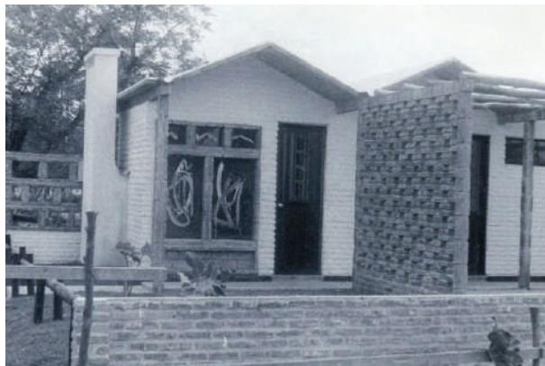
**Fig. VII-28.** Cobertura com pré-moldado de tijolo mais 2.5 cm. de argamassa e pintura. (\*-5).
