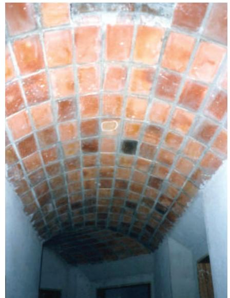
**Fig. V-50.** Forro de corredor ainda sem limpar, com duto de ar condicionado. (\*-5).
