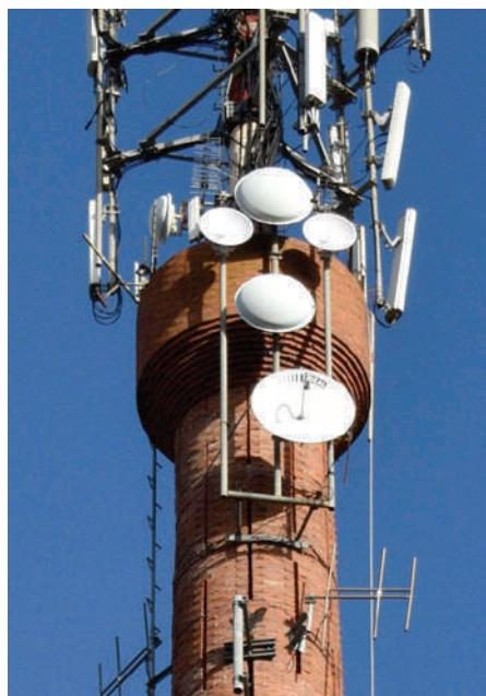
**Fig. I-119.** A fixação das antenas. (\*-5).
