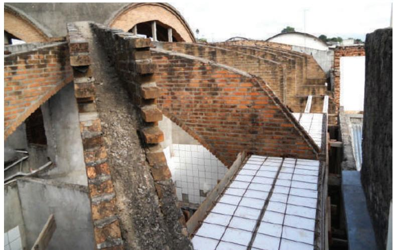
**Fig. VI-34.** Com isolamento térmico (isopor) colocado e apertado pela tela. (\*-5).
