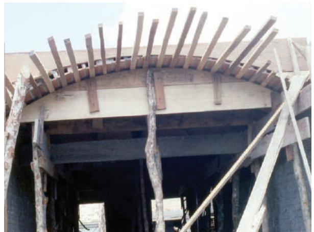
**Fig. V-4.** Nesta figura, se observam os três elementos básicos para montar a abóboda: as costelas, os sarrafos e os tijolos que nesta ocasião são de 2 (dois) furos quadrados. (\*-5).
