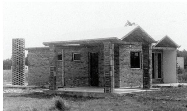
**Fig. VII-35.** Cobertura apoiada nas paredes. (\*-5).
