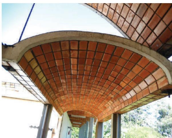
**Fig. III-95.** Passarela cuja abóboda é uma elipse. (\*-5).
