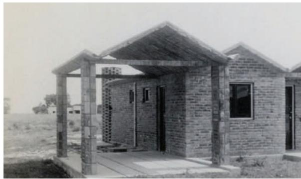
**Fig. VII-34.** Casinha popular, cobertura plissada, parte está apoiada nas paredes e parte é autoportante, na vaga do carro. (\*-5).
