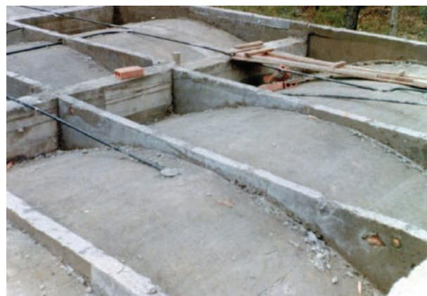
**Fig. V-35.** Nervuras de rigidez de concreto não armado. (\*-5).
