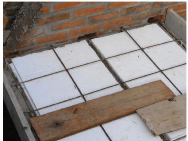
**2 Figs. VI-35.** Com isolante térmico (isopor) e tábuas por onde caminha o operário. (\*-5).
