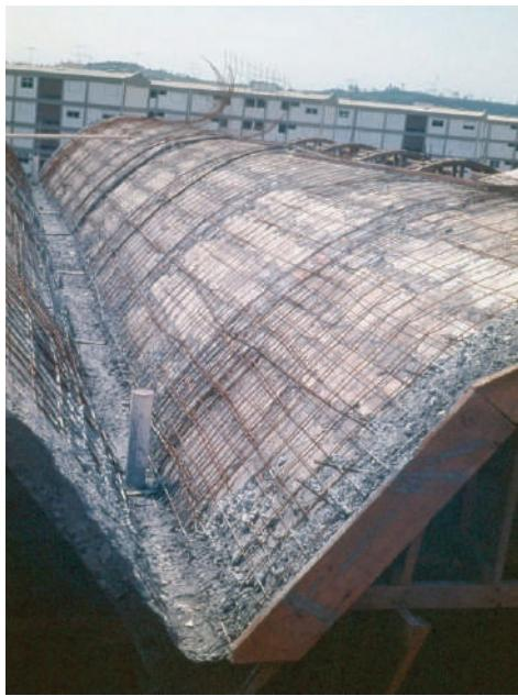
**Fig. III-81.** Armaduras já colocadas e primeira concretagem, vales, nervos e bordas. Neste caso o avanço é lateral. (\*-5).
