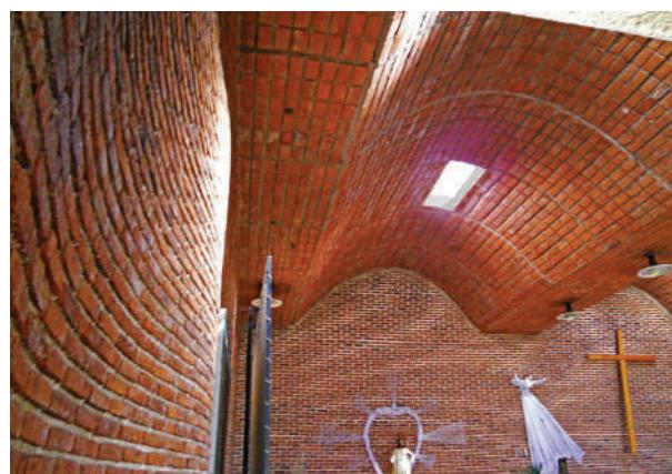
**Fig. XII-106.** A parede não tem janelas para o exterior a fim de dar mais recolhimento, a iluminação é zenital distribuída. (\*-5).
