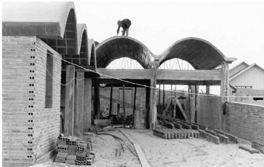
**Fig. IV-7.** Fazendo o acabamento superior, estocagem e cambotas. (\*-5).
