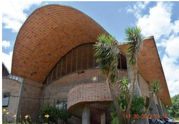
**Fig. I-99.** Os pavilhões da fábrica têm abóbadas de grande corda sem tensor. As forças horizontais são transmitidas pela laje horizontal em míscula e sustentadas pelos pilares reforçados. (\*-5).
