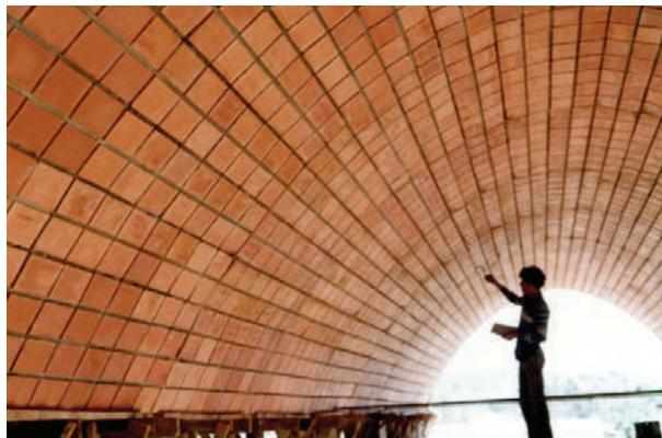
**Fig. III-89.** Sobre um andaime móvel, o operário está limpando as rebarbas e consertando trincas. Observe que os vales ainda estão escorados e só serão revisados e limpos após a liberação total da cobertura. (\*-5).
