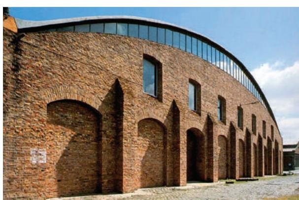
**Fig. I-57.** No depósito do porto de Montevidéu – UY, a cobertura é feita de tijolo armado e, nos extremos, foram aproveitadas as paredes do antigo depósito. (\*-1).
