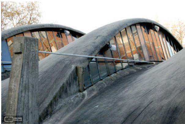
**Fig. I-64.** Detalhe da colocação dos tensores por cima da abóboda. (\*-4.7).
