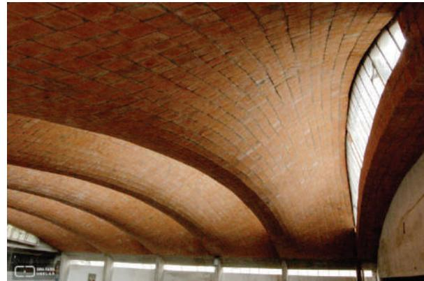
**Fig. I-62.** Ginásio S. F. Sales, Montevidéu, 1983. Vão 24.40 m., flecha da curva 4.70 m. sem tensores por baixo, mas com tensores por cima. (\*- 4.1).
