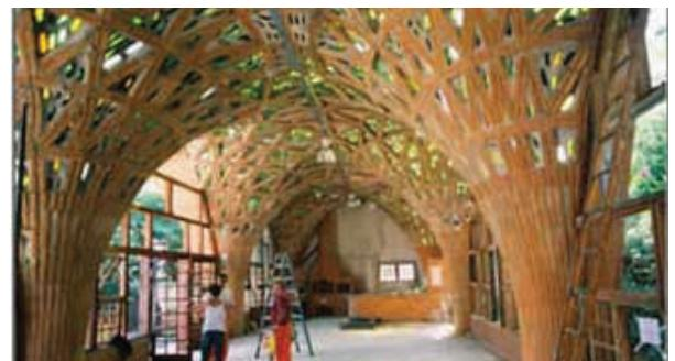
**Fig. X-34.** Vista por baixo, as abóbodas partem de um ponto onde saem as nervuras radialmente. A certa altura, faz-se necessário triangular e por vitrais. (\*-13).
