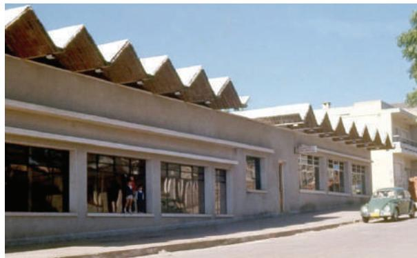
**Fig. VII-14.** Vista externa. O telhado apoiado sobre paredes existentes. (\*-5).
