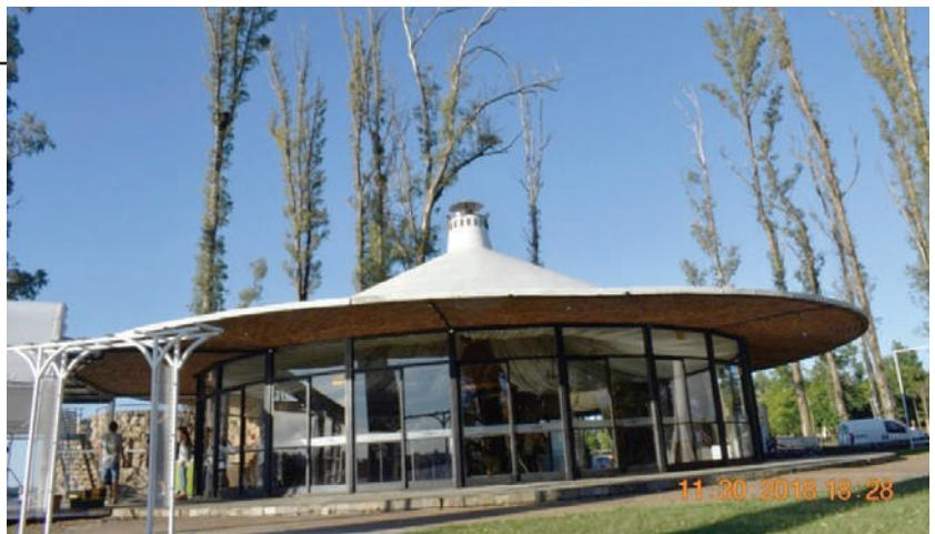
**Fig. I-140.** Restaurante e cafeteria, Salto – UY. (1976). Cobertura em tijolo armado em forma cônica, com abas em mícula. (\*- 5).
