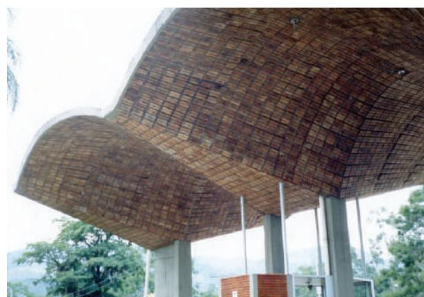
**Fig. IV-97.** Pórtico de entrada e controle, com duplo balanço. (\*-5).
