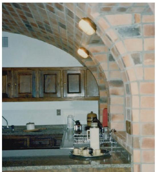
**Fig. V-42.** Está sendo mantida a coordenação das juntas. (\*-5).
