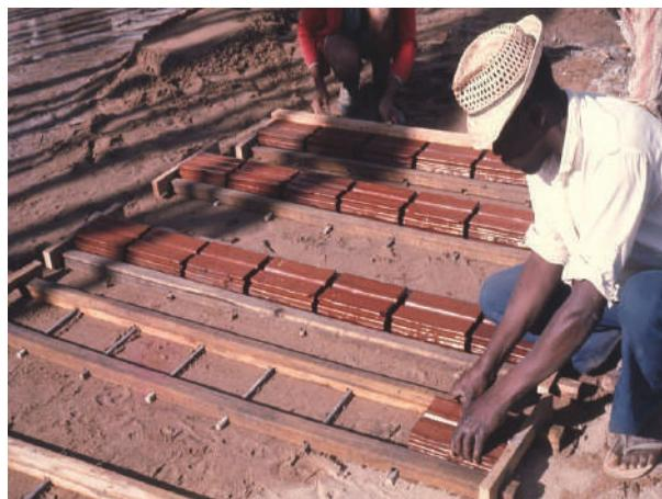
**Fig. III-41.** Pré-moldado com 7 tijolos especiais com 105 de c/lado e 104 na ranhura superior. A face que ficará à vista fica para baixo na moldagem. (\*-5).
