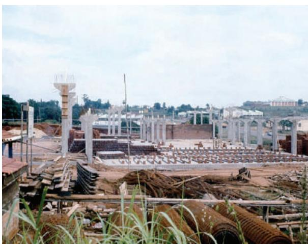
**Fig. III-47.** A pré-moldagem é feita sobre o contrapiso da obra. (\*-5).
