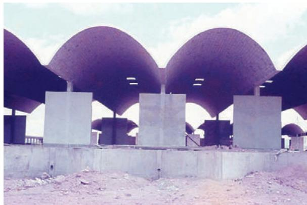
**Fig. I-11.** Abóbadas autoportantes sem tensor atracontraforte vessado para absorver os esforços horizontais. (\*-5).
