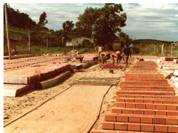
**Fig. III-44.** Pré-moldado com 7 (x2) tijolos comuns de 2 furos, 1,75 de comprimento, à esquerda; o estoque à direita colocados de canto, na primeira hora da manhã para serem limpos das rebarbas da face que ficou para baixo na moldagem. (\*-5).
