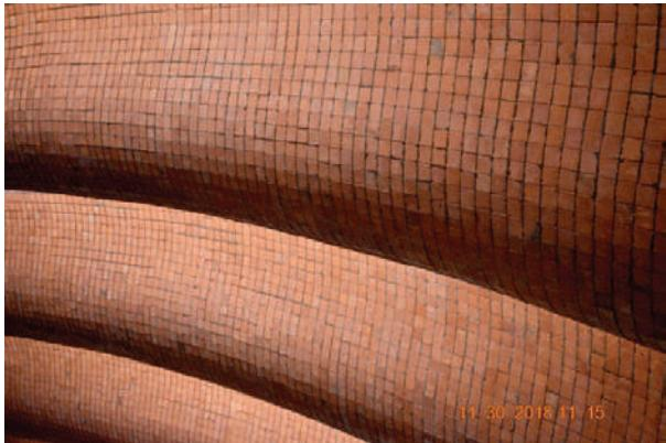
**Fig. I-61.** Ginásio do Colégio Don Bosco Montevidéu (1983). Sem tensores aparentes. (\*- 5).
