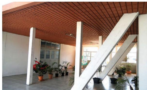
**Fig. IV-67.** As colunas inclinadas transmitem à fundação as descargas da cobertura. (\*-5).
