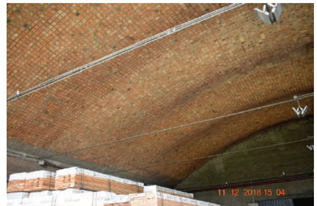
**Figs. I-95 e I-96.** Pertencem a um ginásio na cidade de Artigas – UY, e aos depósitos de uma fábrica na cidade de Rivera – UY.. As ondas na abóboda são necessárias para dar mais rigidez à mesma. A abóboda se comporta como arcos bi-rotulados. (\*-5).
