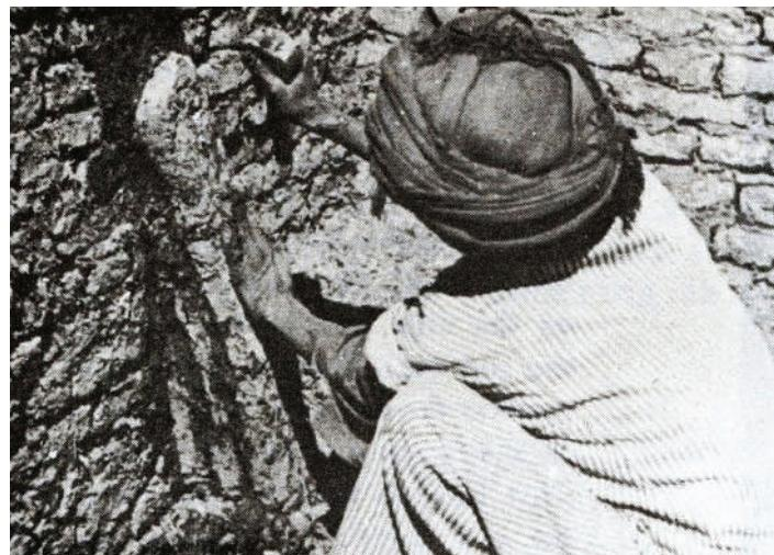
**Fig. X-19.** O pedreiro assentando o tijolo usando uma maceta para afirmar o tijolo. (\*-11).
