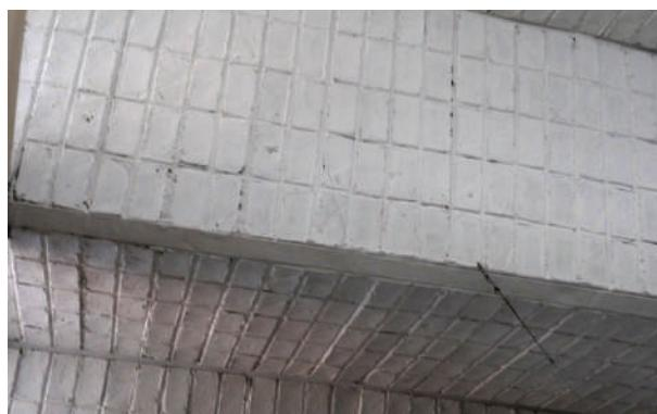
**Fig. VII-18.** O vale pode ser só concreto. Normalmente tem tijolo. (\*-5).
