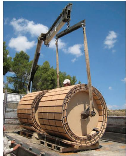
**Fig. X-53 e X-54.** Essas imagens mostram a facilidade do transporte com bobinas das faixas de *Flexbrick*. Vemos também a sua colocação sobre a forma por ocasião da construção da abóboda. (\*-16).
