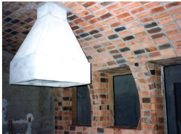
**Fig. V-46.** Neste caso, foi pendurada da abóboda, uma coifa de argamassa armada. (\*-5).
