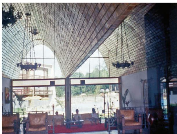
**Fig. IV-99.** Por ser a abóboda uma conoide, observe que a superfície do tijolo se retorce. (\*-5).
