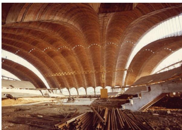
**Fig. XI-23.** Vista interior da cobertura em construção. Em todo o conjunto, pode-se apreciar a magia da cerâmica à vista. (\*-5).
