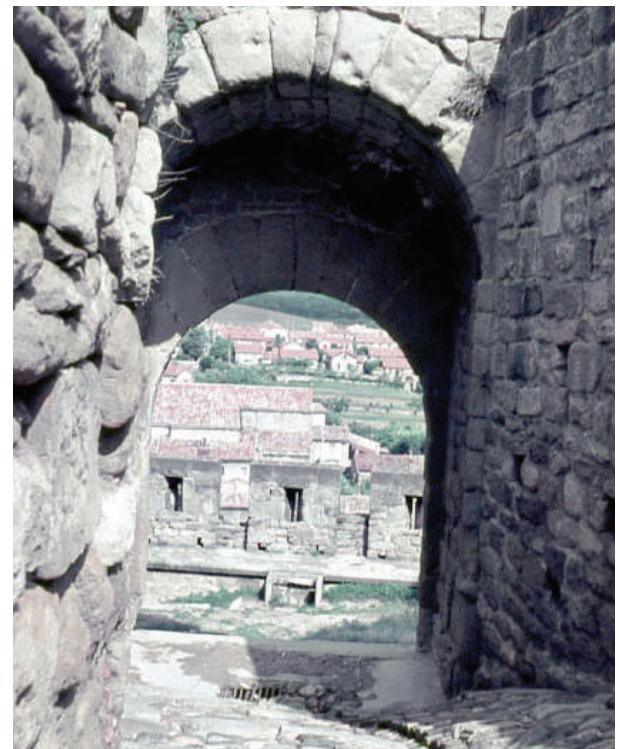
**Fig. II-5.** Arcos com junta seca. (\*-5)
