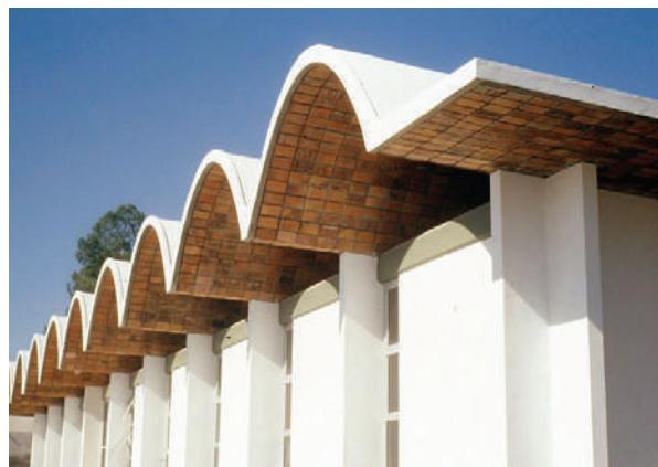
**3 Figs. IV-91.** Toda a cobertura tinha dois módulos de corda das abóbodas, a maior para o ginásio cujo vão é 30 m., e para o resto a corda era a metade. A cinta de arremate das paredes faz a função de tensor. (\*-5).
