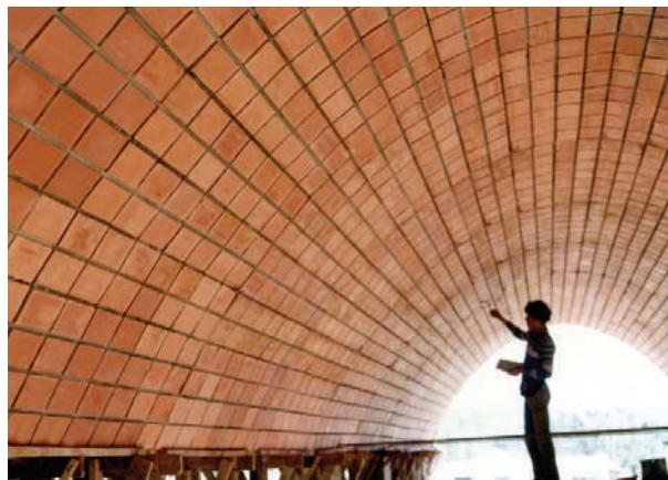
**Fig. III-29.** Trabalho de limpeza de pequenas e poucas rebarbas após tiradas as cambotas, os vales escorados. (\*-5).
