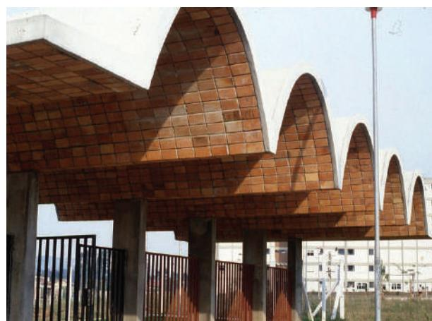
**2 Figs. IV-82.** Vista do pórtico de acesso tem um pilar central com um balanço duplo de 4 m. (\*-5).
