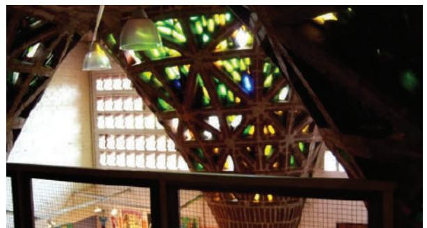
**Fig. X-32.** As linhas curvas (nervuras) de 12 cm. de largura vão deixando espaços entre elas, são triângulos preenchidos com vitral rústico. (\*-13).
