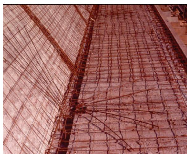
**Fig. III-80.** Armaduras de uma aba extrema lateral, armaduras de repartição e armaduras de espera de um pilar. (\*-5).
