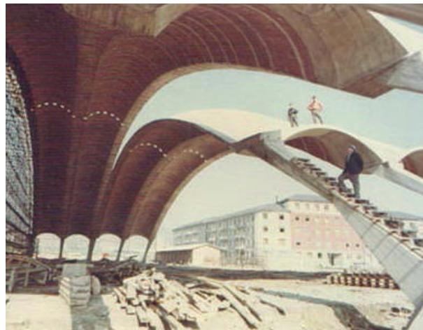
**Fig. XI-9.** Antes da montagem estão prontos os contrafortes, as articulações e os cabeçalhos de espera da abóboda cerâmica. (\*-13).
