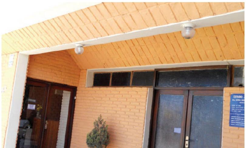
**Fig. VII-11.** Cobertura do hall com tijolo à vista pintado igual que a parede. (\*-5).
