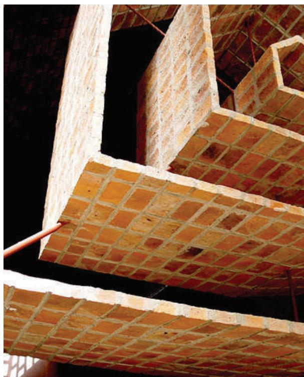
**Fig. I-138.** Detalhe da rosácea. Em parte foi usado o princípio estrutural da roda de bicicleta. (\*-2).
