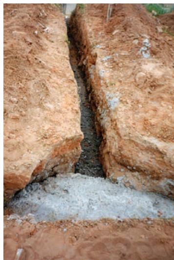
**Fig. IX-16.** Detalhe do “merto” preenchido e dos tensores já recobertos. Não se devem colocar formas. (\*-5).
