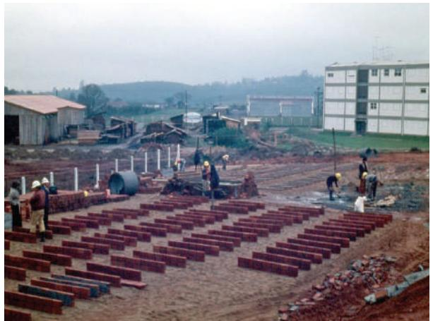
**Fig. III-46.** Pré-moldagem no canteiro de obra, na primeira hora da manhã. (\*-5).
