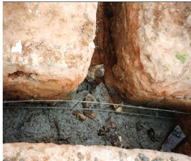
**Fig. IX-15.** Detalhe do enchimento do “merto” com concreto ciclópico. As armaduras principais são uma grelha, mais armaduras adicionais, os tensores atravessam até o outro lado. (\*-5).
