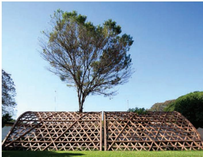
**Fig. X-44.** Vista externa da abóboda vazada em tijolo armado. (\*-15).
