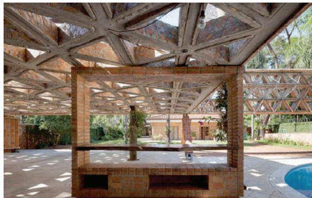
**Fig. X-47.** Laje horizontal vazada com treliçamento em tijolo armado. Os pilares são de tijolo armado. (\*-15).
