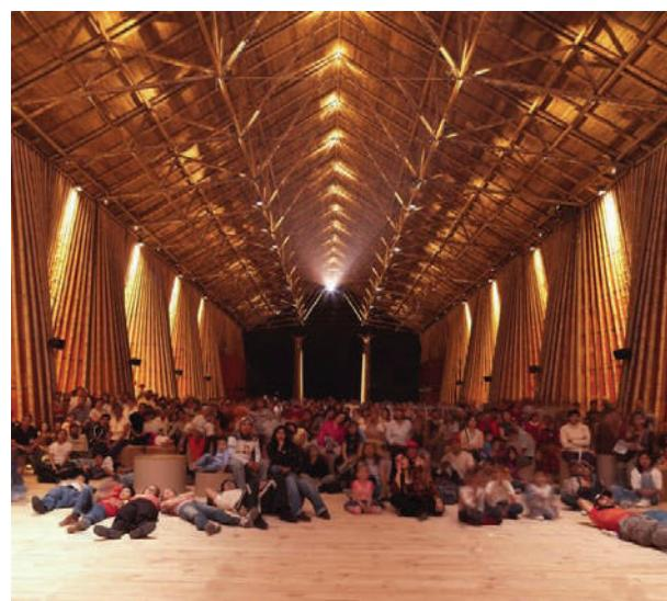
**Fig. X-38.** Altas paredes feitas com nervuras. O movimento das paredes acrescenta sua resistência. (\*-13).
