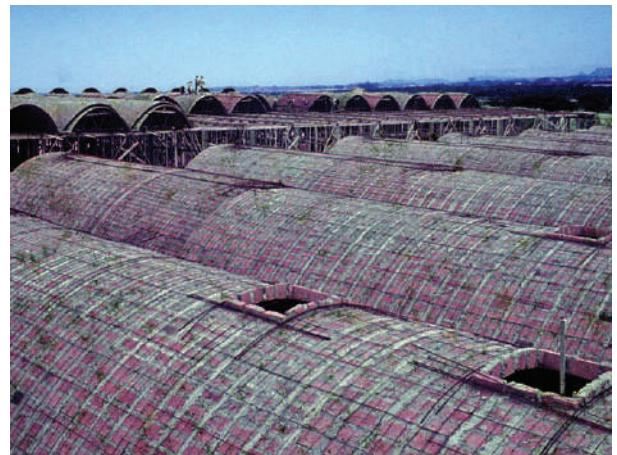
**Fig. I-10.** Ao longe, um conjunto de abóbodas em montagem, onde se vê na sua continuação os vales escorados previamente. (\*-5).
