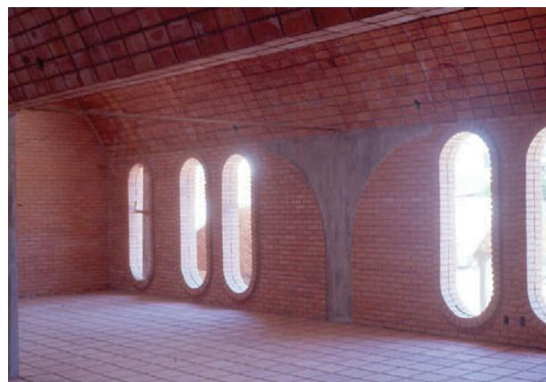
**2 Figs. IV-76.** Vista externa. Estrutura à vista na parede. Iluminação com janelas oval e lanternim zenital. (\*-5).
