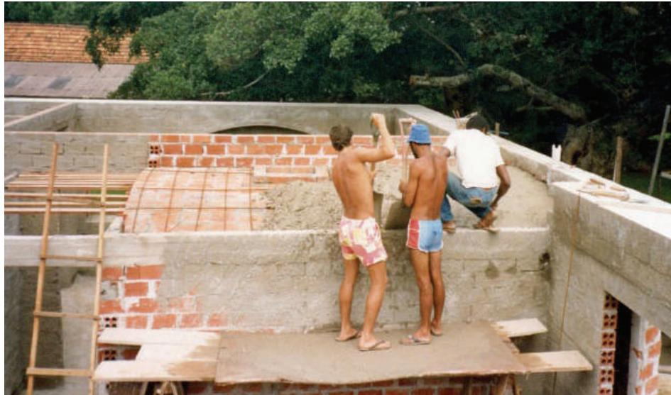
**Fig. V-33.** Abóboda autoportante com armaduras e camada de concreto. (\*-5).
