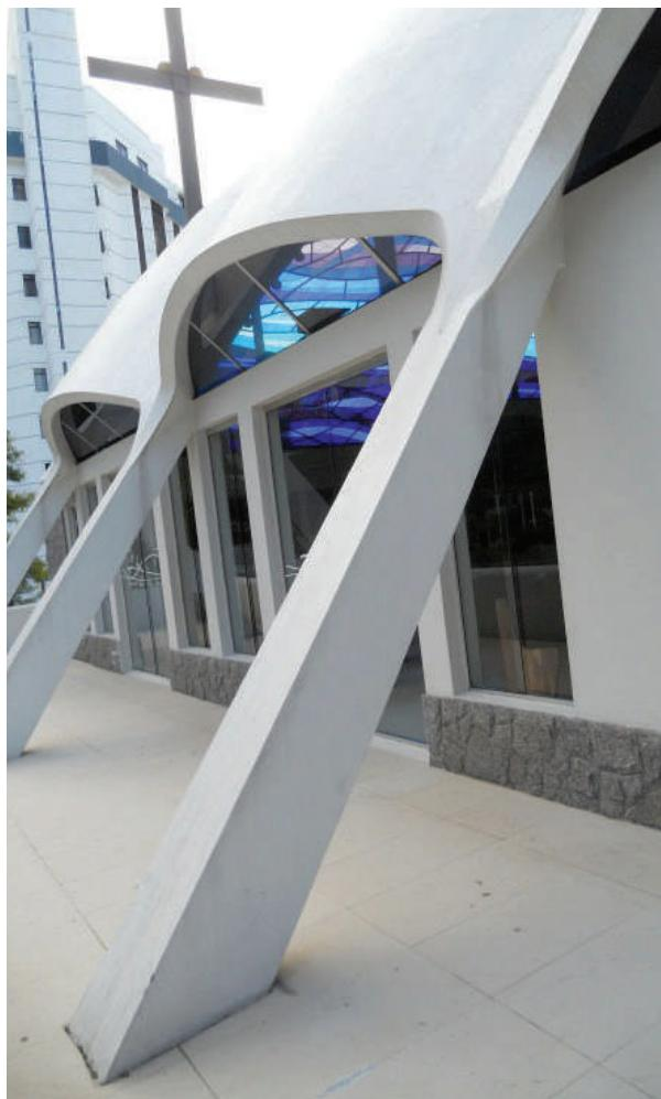
**Fig. IV-43.** As colunas inclinadas oficiam de "arc-boutant". (\*-5).
