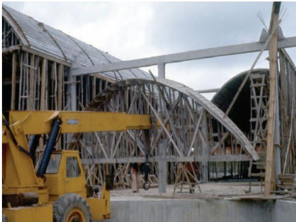
**Fig. III-52.** Guindaste movimentando a cambota especial do inicio. (\*-5).
