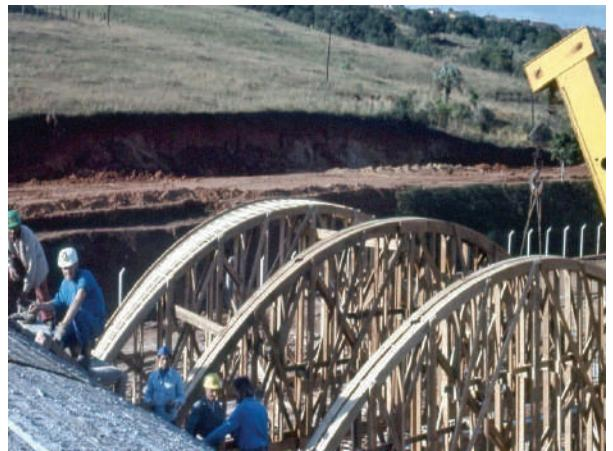
**Fig. III-109.** Avanço lateral com cambota especial no extremo. (\*-5).
