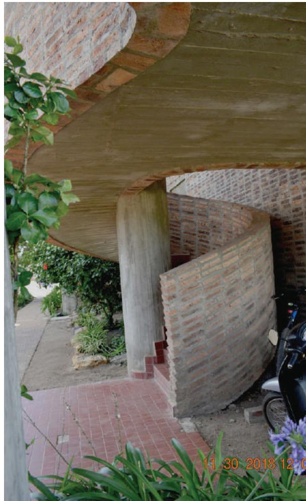
**Fig. I-101.** A parede helicoidal de tijolo armado sustenta a escada. (\*-5).
