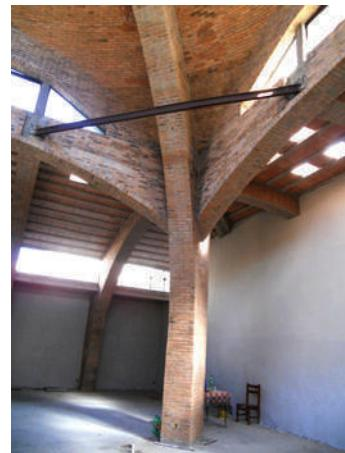
**Fig. VIII-60.** Viga sextavada de perfil de ferro e encontro do arco cruzado com as vigas-arco dos lados do quadrado central. (\*-5).
