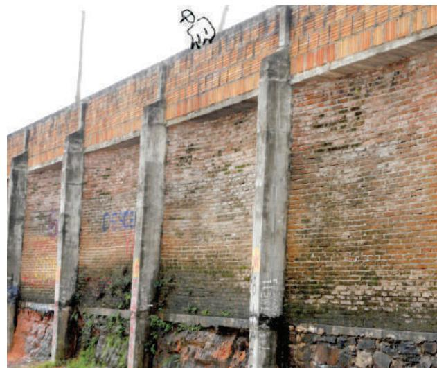
**Fig. IX-17.** O muro-abóboda terminado com a mureta superior, a laje superior no tímpano da abóboda e a laje inferior sobre rocha arenita, base do muro de arrimo. (\*-5).
