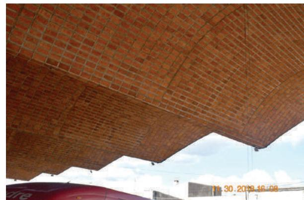
**Fig. I-77.** O balanço de 12.50 m. libera as manobras dos ônibus. (\*-5).
