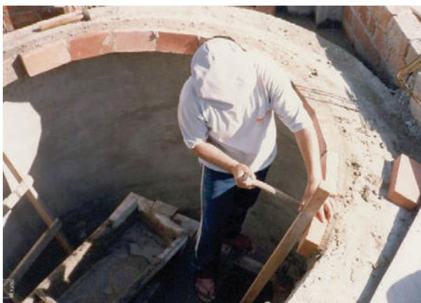
**Fig. VIII-13.** O pedreiro apertando o tijolo na fiada da cúpula. (\*-5).
