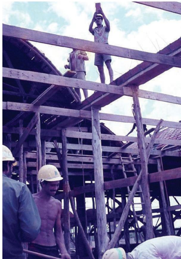
**Fig. I-6.** Como a altura é grande, o operário de baixo coloca o tijolo em uma pá para lançá-lo para o operário de cima. (\*-5).
