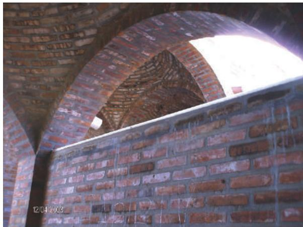
**Fig. VIII-82.** Detalhe do encontro da parede, o arco, a coluna e a cúpula. (\*-5).
