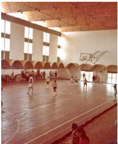
**Fig. IV-83.** Vista interior do ginásio de esporte, cobertura feita com o sistema de pré-moldados e cambotas e também pós-tensada. (\*-5).
