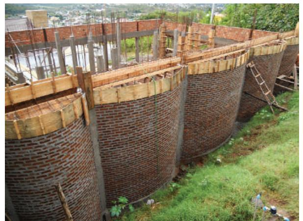
**Fig. IX-9.** Observe a laje na meia-lua que fará de enrijecedor do muro-abóboda. Externamente, o muro de arrimo será impermeabilizado. (\*-5).
