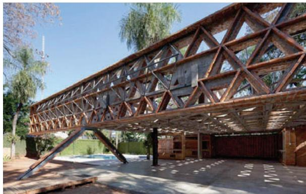
**Fig. X-46.** Estrutura treliçada feita com barreiros de tijolo armado. (\*-15).
