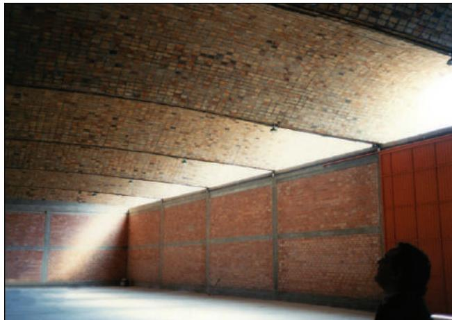
**Fig. XI-28.** Vista interna do depósito de vão de 35 m.. Avista-se a contraflecha pronunciada. (\*-5).
