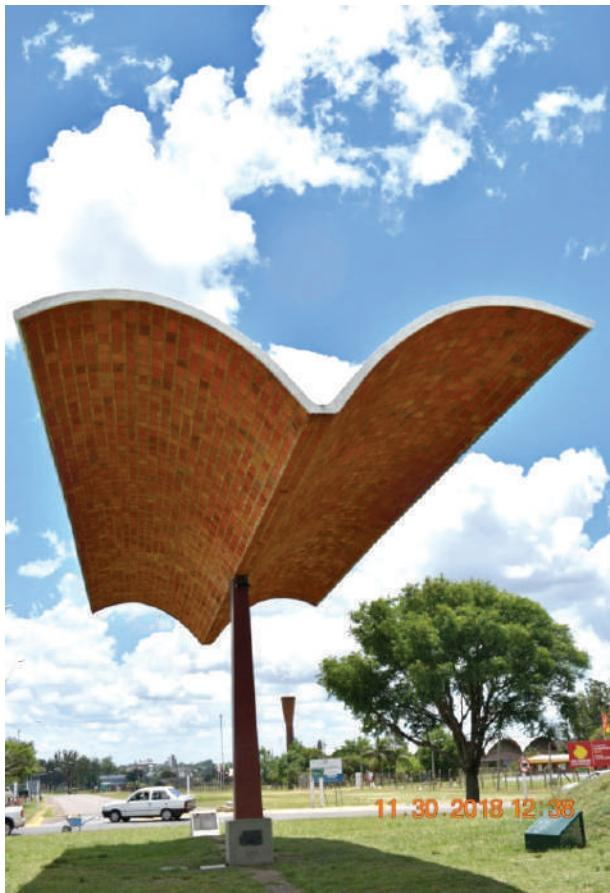
**Fig. I-2.** Outra vista das asas de gaivota, este é o símbolo da viga autoportante das abóbadas. (\*-5).
