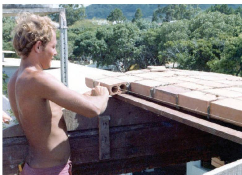
**Fig. V-30.** Colocando os tijolos. O pedreiro acrescentou um mini andaime sobre a plataforma do andaime para estar na altura adequada com os cuidados de uma parede normal de espelho. (\*-5).
