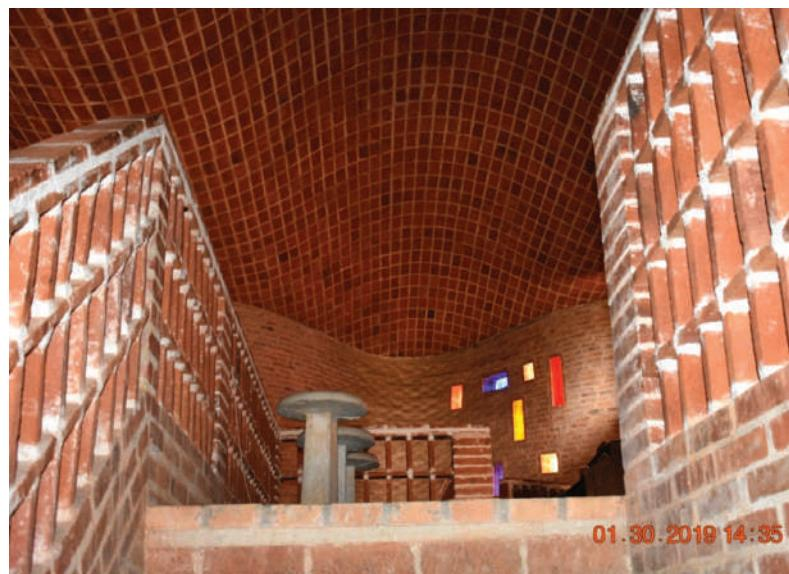
**Fig. XII-24.** A escada com seus guarda corpos em tijolo e, ao fundo, a união rígida da parede com a cobertura. (\*-5).
