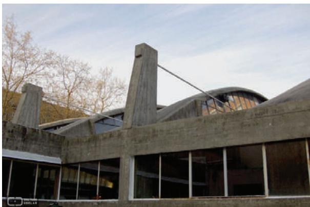
**Fig. I-63.** O mesmo ginásio no Colégio Don Bosco. Detalhes dos tensores por cima da cobertura. (\*- 4.7).
