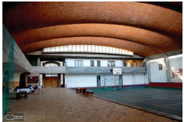
**Fig. I-65.** Vista interior do ginásio, visualmente limpa, sem tensores. Permite baixar a altura dos pilares. Vão 24.40 m., flecha 4.70 m. (\*- 4.3).
