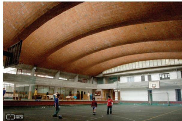
**Fig. I-60.** Ginásio do Colégio Don Bosco Montevidéu (1983): vão 24.40 m., flecha 4.70 m.. Sem tensores aparentes. (\*-4.1).
