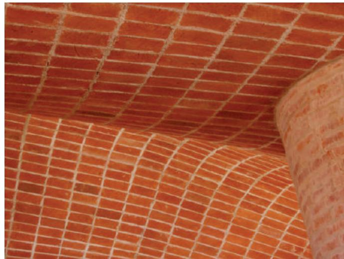
**Fig. XII-22.** Nó rígido na junção da parede e a cobertura. (\*-4.2).
