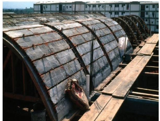
**2 Figs. III-107.** Perto do fim da obra, juntaram-se todas as cambotas dos outros pavilhões e se faz a montagem com avanço lateral. (\*-5).
