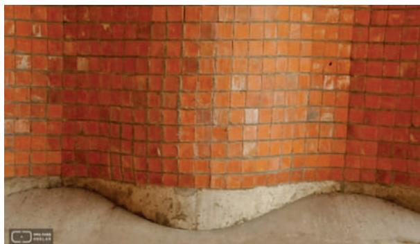
**Fig. I-128.** Bases de concreto recebendo os arcos-ondas em graneleiro com fundo em V. (\*-4.4).
