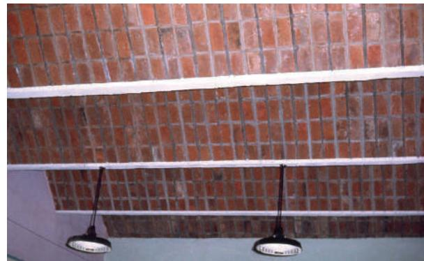
**Fig. VII-15.** A cobertura recém feita. Nota-se a diferença entre a junta do pré-moldado e a junta em obra. O tijolo está à vista antes de ser pintado. (\*-5).
