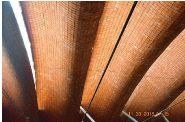
**Fig. I-55.** Depósito de cítricos Caputto. Quando se tem a necessidade de sacar canos, exaustores ou chaminés sempre se fazem pelas aberturas, ou seja, as partes separadas da cobertura. (\*-5).
