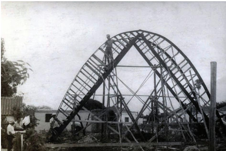
**Fig. IV-15.** Só duas (2) cambotas econômicas para toda a obra. Curva anticatenaria. (\*-5).
