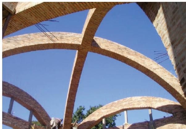
**Fig. VIII-37.** 1<sup>a</sup> Etapa de construção onde são feitos os arcos diagonais que já comportam os 4 pilares e os arcos-viga. (\*-5).
