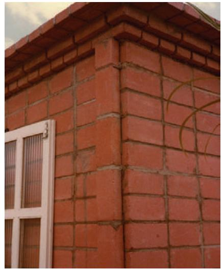
**Fig. XI-65.** Com pequenas saliências dos tijolos se faz uma beira com desenho que lembra as antigas, e que muda o cimento do telhado, dando um balanço protetor das águas da chuva na parede. (\*-5).
