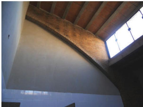
**Fig. VI-42.** Vista semiarco com iluminação e abóboda industrializada. (\*-5).
