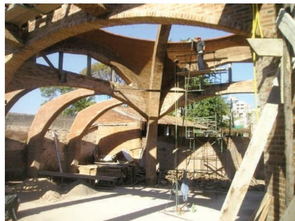
**Fig. VIII-44.** A cúpula está ultrapassando a altura dos arcos laterais do quadrado central onde se apoia. Já estamos no momento de fazer o anel de armadura. (\*-5).
