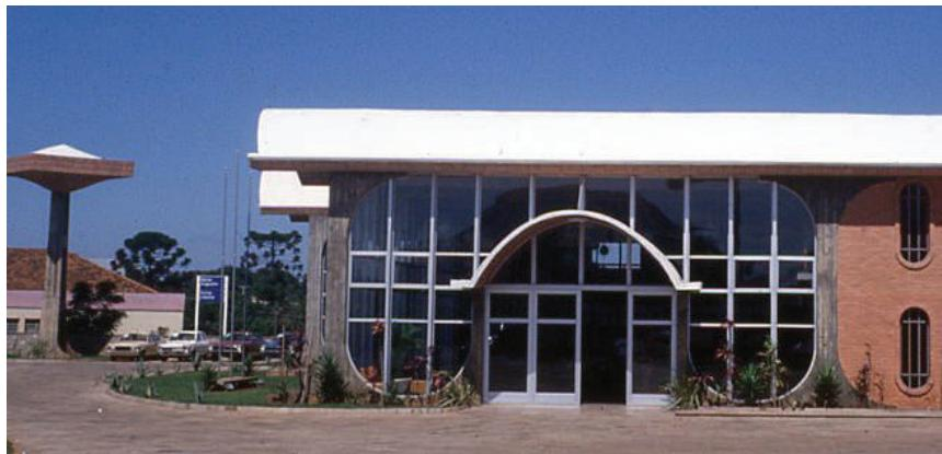
Para este tipo de caixa d'água, o pilar poderá ter diversos tipos de formatos, principalmente quando se faz em tijolo armado.
