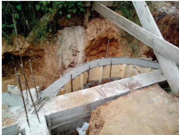
**Fig. IX-4.** Viga curva para o muro e viga baldrame reta que faz de tensor. (\*-5).
