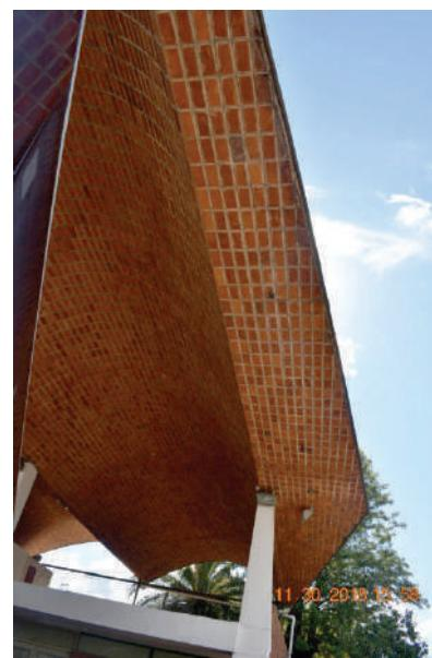
**Fig. I-79.** A aba lateral tem a função de viga laminar horizontal e está em balanço. Está apoiada no vale da abóboda e não permite que o arco do extremo da abóboda se abra. (\*-5).
