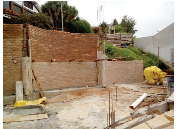
**Fig. IX-5.** 1<sup>a</sup> etapa: feito o muro, é preenchido o pilar; 2<sup>a</sup> etapa: para cima, feito primeiro o muro e voltar a preencher o pilar. (\*-5).
