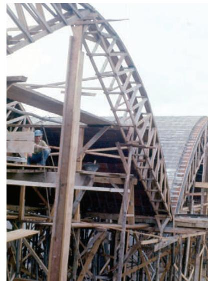
**Fig. III-57.** Corda de 12 m., vão longitudinal 36 m., Apomedil - Lajeado/RS. (1975). Esta cambota "Separada" é mais larga para que se possa pôr sobre ela só o fundo do tijolo especial e fazer um arco reforçado como o do detalhe (Fig. III-50). (\*-5).
