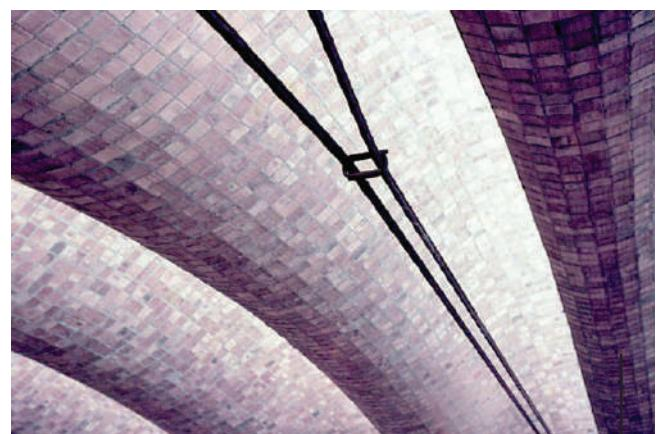
**Fig. I-46.** Mostra o método de pós-tensão dos tensores. Dois (2) anéis de aço são colocados no centro do vão e se vai deslizando para os extremos até que o Eng. da obra o considere suficientemente esticados. (\*-5).
