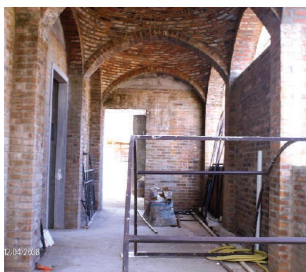
**Fig. VIII-81.** Só com tijolo e argamassa e um pequeno andaime fizemos nossa construção. (\*-5).
