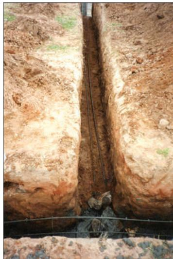
**Fig. IX-14.** Vista de todo o tensor, desde o pilar até o “merto”, os tensores serão revestidos em concreto. Observe o corte vertical do terreno o que permite eliminar as formas. (\*-5).
