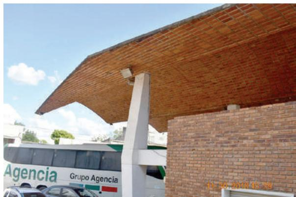
**Fig. I-76.** Pilar do extremo, devido a ser dupla altura a laje e sua viga na metade da altura, comportam-se como tensores. O pilar está reforçado. (\*-5).
