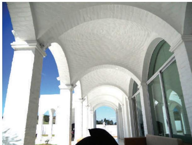
**Fig. VIII-86.** Nota-se a textura da cúpula com tijolo a vista pintado. (\*-5).
