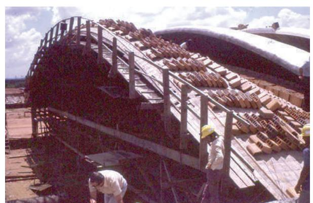
**Fig. I-42.** A forma está na posição correta. Foram depositados sobre a mesma os tijolos, que serão posicionados. (\*-5).
