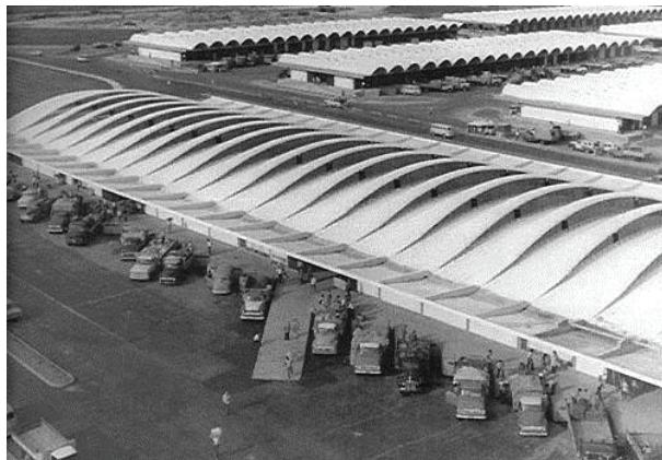
**Fig. I-44.** Vista superior parcial do conjunto da CEASA em Porto Alegre, BR. em funcionamento. Em primeiro plano, o pavilhão dos produtores com cobertura Gauss, repetida 20 vezes. (\*- 1).
