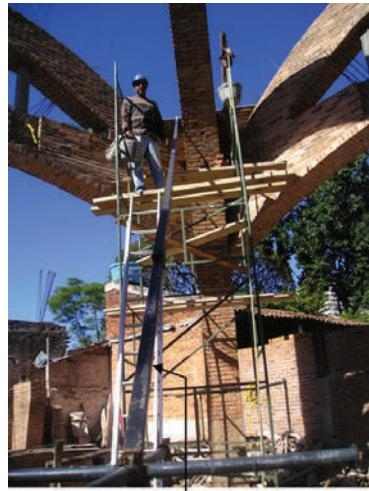
**Fig. VIII-41.** Este é o começo da cúpula onde o seu raio guia (cintel) vai do centro da cúpula ao tijolo que vai ser colocado na cúpula. (\*-5).
