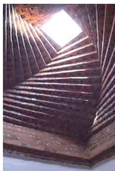
**Fig. X-36.** Iluminação e ventilação zenital feita com nuras pré-moldadas colocadas horizontais em posição dentada. (\*-13).
