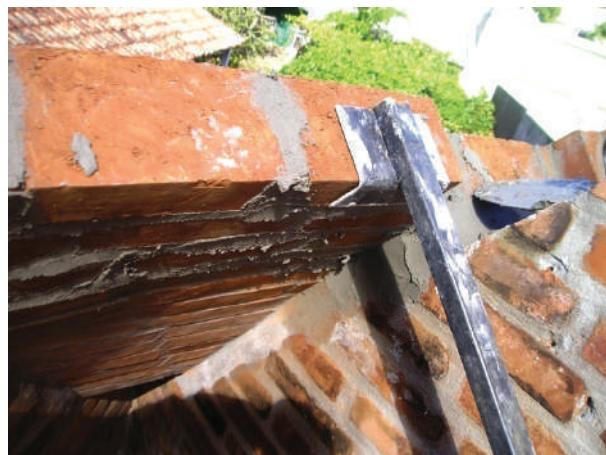
**Fig. VIII-43.** Tijolo maciço recém colocado, sustentado pelo cintel. Pode-se ver o arco central diagonal à direita. (\*-5).
