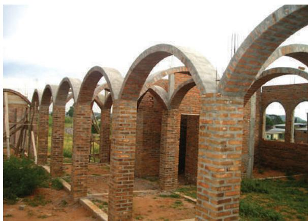
**Fig. VIII-78.** Depois das colunas, o primeiro que se faz são os arcos com cambotas. Fazem-se os arcos sem armadura, logo com o centro e o cintel (raio) se fazem as cúpulas sem armadura. (\*-5).
