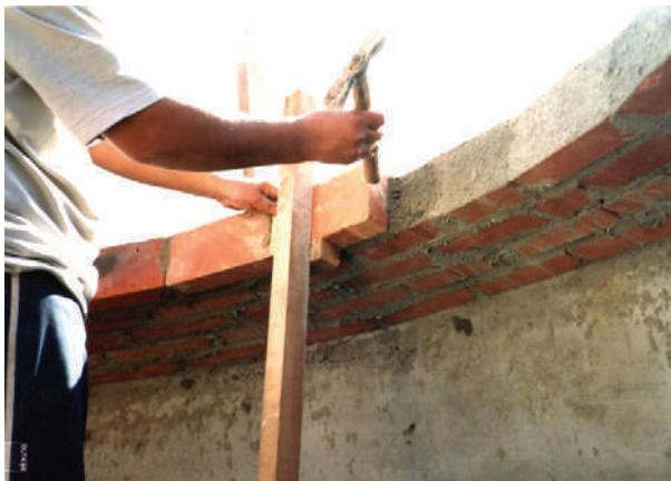
**Fig. VIII-11.** O pedreiro está colocando e apertando o tijolo. Em decorrência de ser o tijolo muito liso, dá-se um salpique na face dos próximos tijolos para que a argamassa adira mais rápido, e o próximo tijolo colocado não escorregue para baixo; este salpique se pode fazer nos tijolos antes de começar a cúpula. Nota-se que o tijolo se apoia na travessa do cintel. (\*-5).
