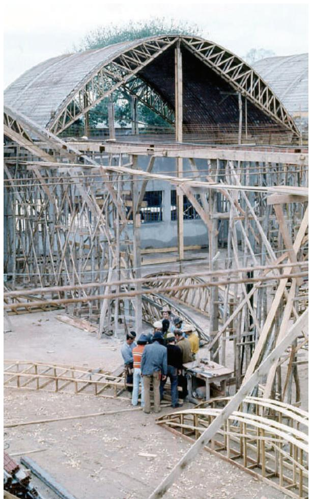
**Fig. III-54.** Nesta obra, usaram-se cambotas divididas. Nota-se, no chão, o quadro da cambota e algumas quase prontas. (\*-5).
