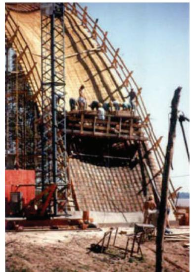
**Figs. I-120 e I-121.** Da esquerda para a direita. As costelas da forma começam a ser revestidas de tábuas de madeira. A abóboda de tijolo começa a ser construída pelos operários. (\*-1).
