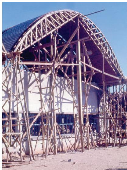
**Fig. III-56.** Cambotas divididas em duas para dar leveza, com corda de 12 m. Apomedil - Lajeado/RS. (1975). (\*-5).
