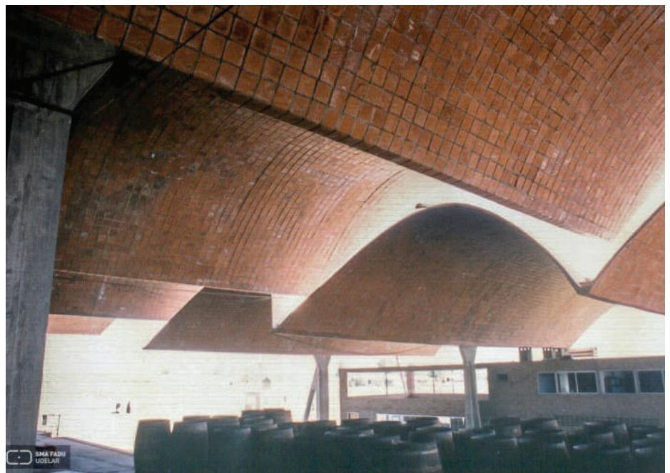
**Fig. I-68.** Agroindústria Massaro. Vistas interiores com abóbadas em duplo balanço de 15 m., com coluna extrema especial para sustentar a força H horizontal. (\*-1).
