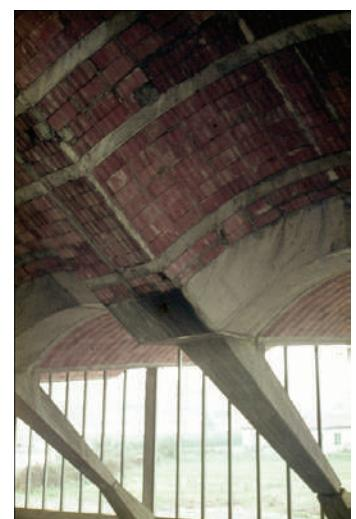
**Fig. XI-16.** Vista por dentro do cabeçalho de concreto que recebe a cobertura. (\*-5).
