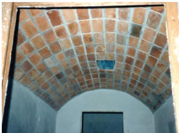
**Fig. V-47.** Forro de banheiro comduto de ar condicionado. (\*-5).
