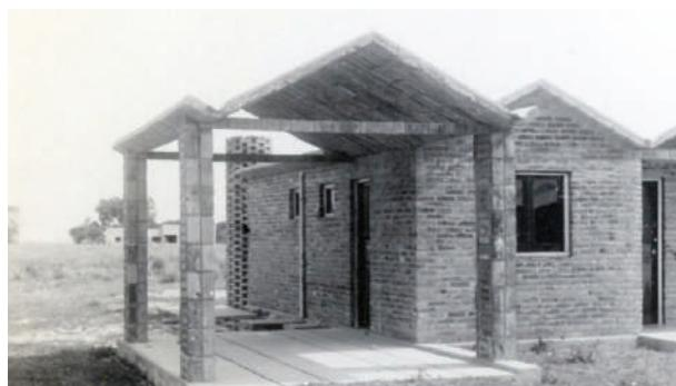
**Fig. XI-75.** Esta casinha não é das mais econômicas, seu telhado numa parte é autoportante e em outra parte está apoiado sobre as paredes. Observe que tem uma viga tensor e os pilares são de tijolo armado. (\*-5).
