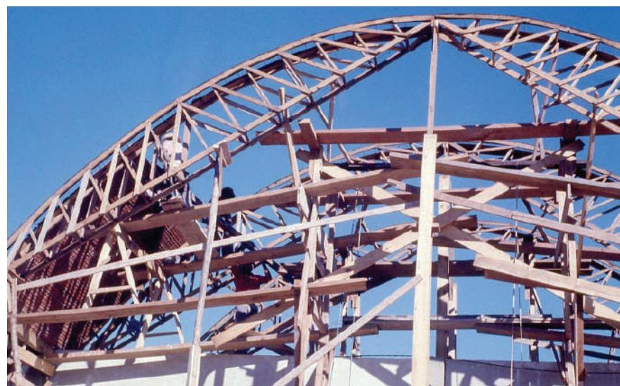
**Fig. III-58.** Cambotas divididas em duas para dar leveza, e separada fica mais larga para fazer o arco de reforço transversal maior e mais resistente (vide detalhe Fig. III-49). (\*-5).
