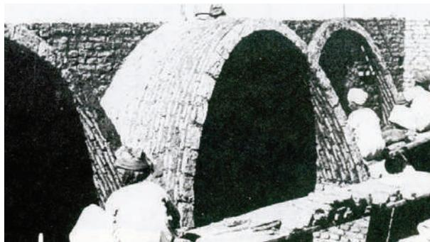
Observando tudo, constatamos que o sistema não usa formas (importante para o Egito). A madeira usada são tabuões para andaimes apoiados nas paredes e, quando precisar, usam-se escorras. Neste caso, os vão são de + 3.00 m..
