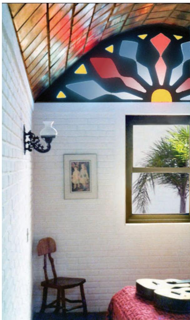
**Fig. IV-11.** Os vidros dos vitrais são fixados em divisões de concreto pré-moldado dividido em 4 partes separadas. Algumas meia-luas levam só 2 partes, como neste caso. (\*-5).
