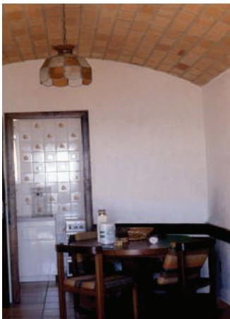
**Fig. V-39.** Uma vista da sala e da cozinha com o forro de tijolo à vista. (\*-5).
