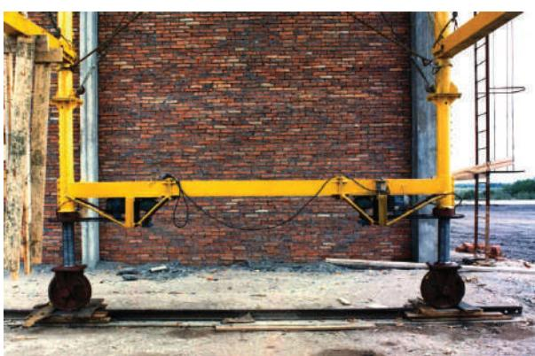
**Fig. I-41.** Andaiques mecanizados idealizados por Dieste para elevar e baixar as formas das abóbodas. (\*-3).
