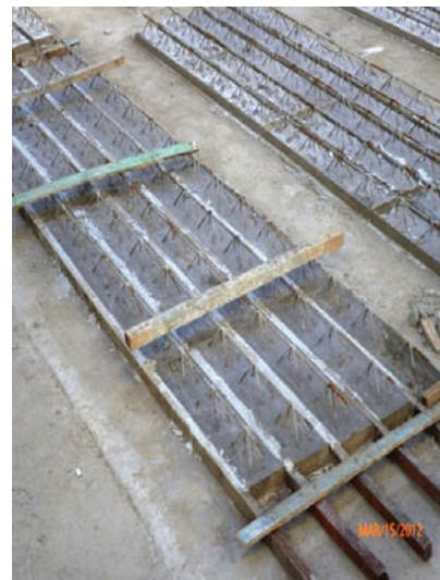
**Fig. VI-20.** Fabricação própria de vigotas. (\*-5).
