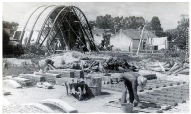
**Fig. IV-24.** Os pré-moldados retos ou curvos se fazem no canteiro de obra. (\*-5)
