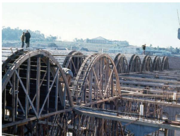
**2 Figs. III-106.** Avanço frontal, 2 cambotas por abóbadas. Neste caso, as cambotas são do tipo "separadas". (\*-5).
