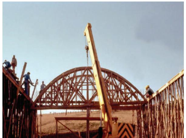
**Fig. III-51.** Mostra um guindaste móvel colocando a cambota. Será sustentada até que seja escorada e travada com as outras. (\*-5).
