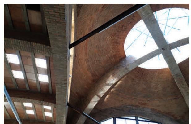
**Fig. VIII-31.** Observam-se as vigas metálicas que fazem o sextave e que absorvem os esforços horizontais do “arc boutante”. À esquerda da figura, abóbadas industrializadas são vistas. (\*-5).
