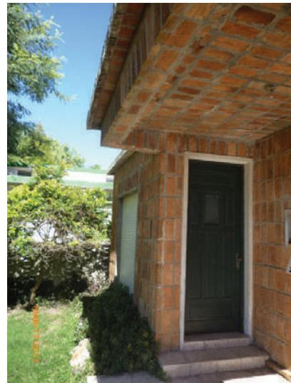
**Fig. XI-69.** Viga e laje de tijolo
