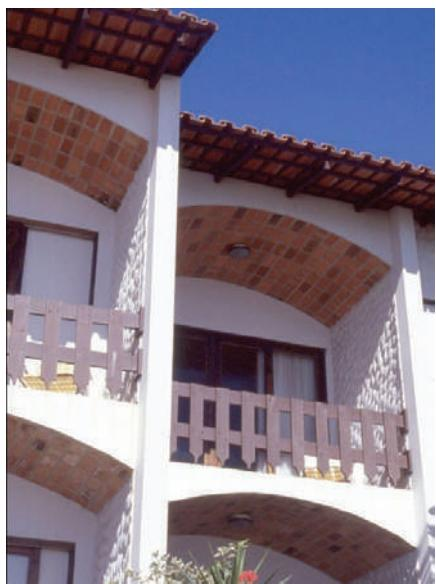
**Figs. V-3.** A posição e a junta dos tijolos é perfeita. Querendo se podem colocar tijolos mais claros ou mais escuros, ou mesmo com a face vitrificada. Também se pode aplicar um verniz especial. Neste exemplo, algumas abóbadas são para entrepisos enquanto outras apenas para forros. (\*-5).
