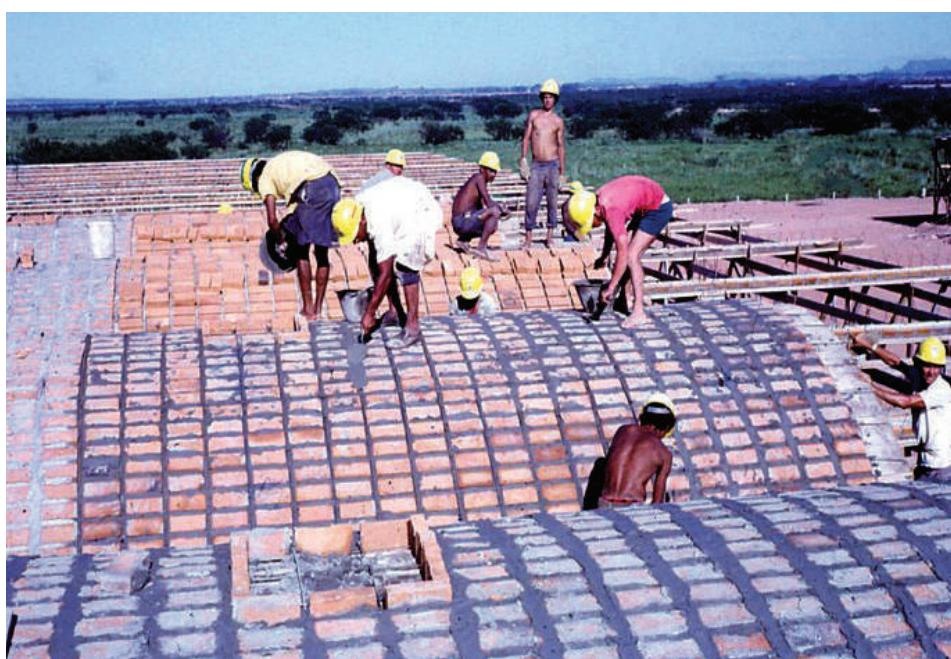
**Fig. I-7.** Nesta figura, temos um flash geral das diversas operações que se realizam sobre as formas para fazer as abóbodas. (\*-5).
