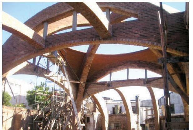
**Fig. VIII-38.** 2<sup>a</sup> e 3<sup>a</sup> Etapa de construção onde são feitos os semiarcos diagonais e os semiarcos laterais, já estão colocadas as vigas sextavadas. A cúpula começou a ser feita. (\*-5).
