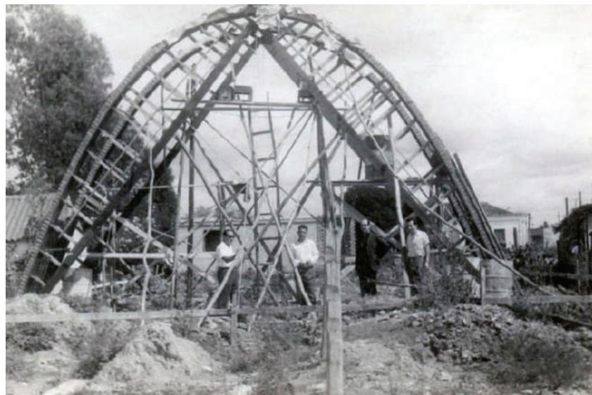
**Fig. IV-21.** Devido à capacidade resistente do tijolo, o arco tem uma camada inferior e outra por cima da cobertura com armadura no meio. No arco, o concreto não devia existir. (\*-5).
