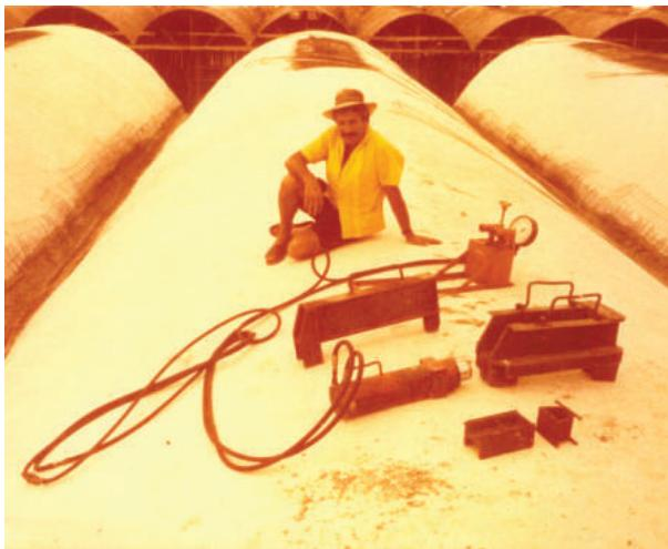
**Fig. I-35.** O pinçado se faz com um sargento hidráulico, como o da figura. O manômetro vai dando, instantaneamente, a força  $F$  que, de acordo com a geometria ou um strain-gage (extensômetro), permite encontrar o valor das forças  $F_1 \times 2$ . Tem-se pronto um anel em duas metades que se soldam no lugar e, com isso, fixa-se a posição das armaduras “ $\ell$ ”. (\*-1).
