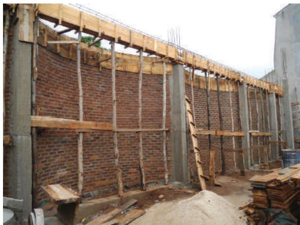
**Fig. IX-8.** Vista interior, preparando para a laje de entrepiso com viga que faz de tensor. (\*-5).
