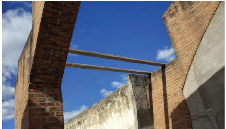
**Fig. VI-22.** Duas (2) vigotas colocadas para laje horizontal. (\*-5).
