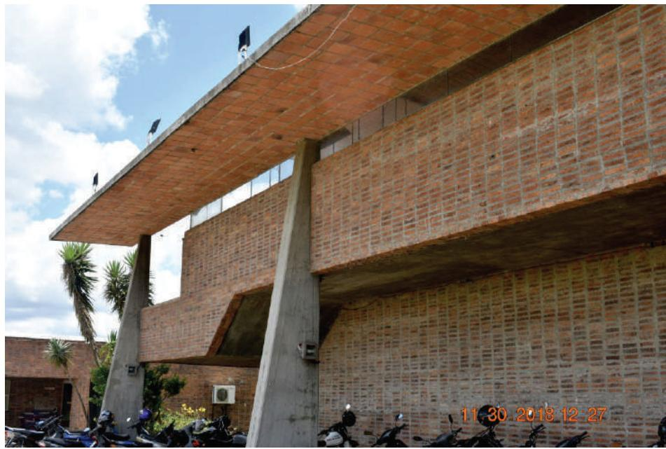
**Fig. I-98.** Obra Venturini em Salto - Uruguai. Os pilares são dimensionados para receber os esforços horizontais da abóboda, levados pela laje horizontal. Entre os pilares a parede - viga armada. (\*-5).
