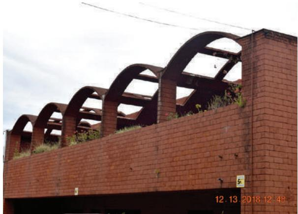
**Fig. XII-34.** Sobre o terraço da sacada, temos as abóbodas autoportantes pergoladas, que não precisam de vigas. Isto é uma novidade das abóbodas. (\*-5).
