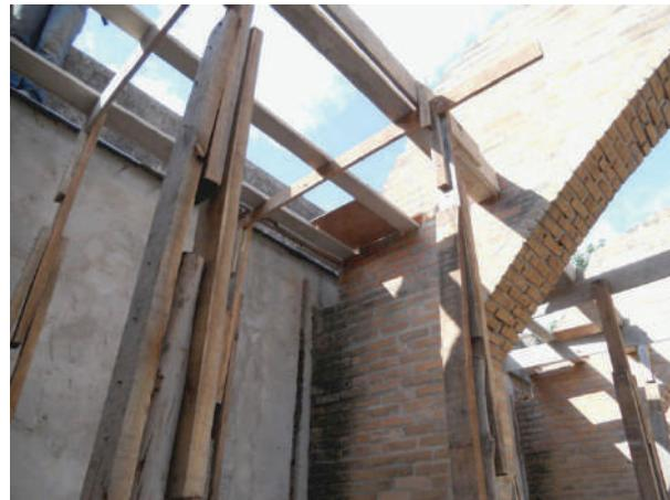
**Fig. VI-28.** As costelas colocam-se antes das placas (\*-5).
