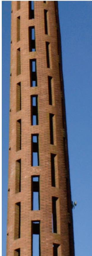
**Fig. I-117.** Detalhe do vazado da torre, observe que os vazios se vão estreitando na medida que sobe a torre, porque diminuem o raio. (\*-5).
