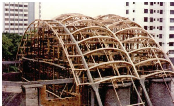
**Fig. IV-52.** No começo do telhado, colocam-se cambotas guias para duas fatias curvas da cobertura e a aba reta que estará cruzando sobre a cúpula (vide foto anterior). O vale vai de um pilar de um lado a outro. Os pilares com capitel em "V" já estão feitos. (\*-5).
