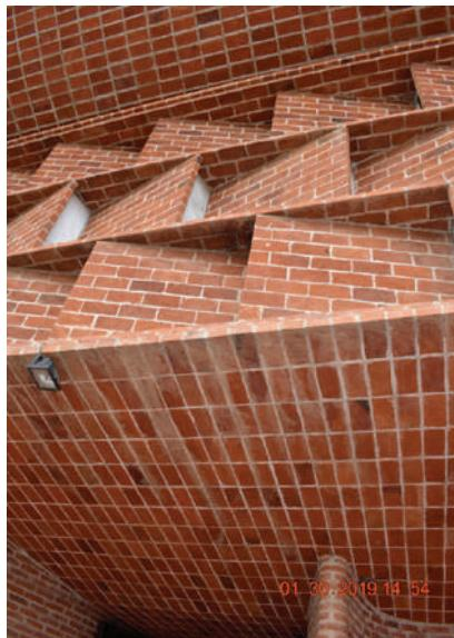
**Fig. XII-25.** Vista externa por baixo da lámina do mezanino com tijolo de espelho. Na parte superior da foto, observa-se a lámina da cobertura em dupla curvatura. (\*-5).
