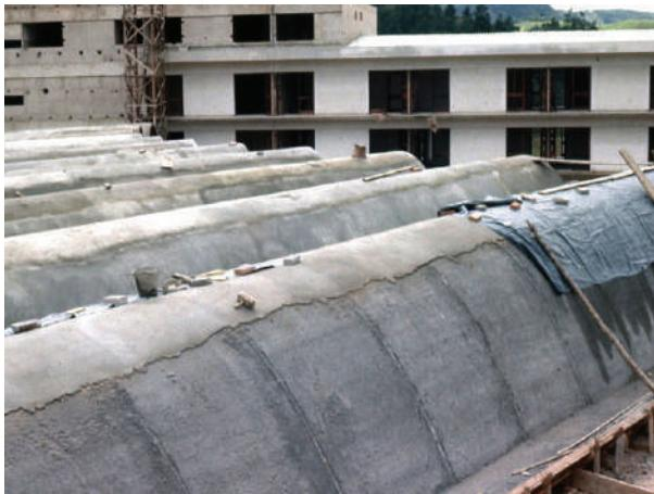
**Fig. III-87.** Exemplo de acabamento com camada fina desempenada. (\*-5).
