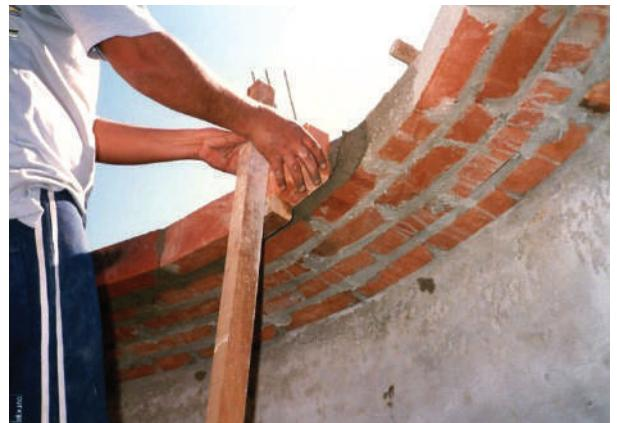
**Fig. VIII-10.** O pedreiro está colocando o tijolo encostado na argamassa e o apoiando no cintel. O cintel ou raio da cúpula é um sarrafo de madeira bem simples, na sua ponta de baixo tem um prego que apoia no centro da cúpula. (\*-5).
