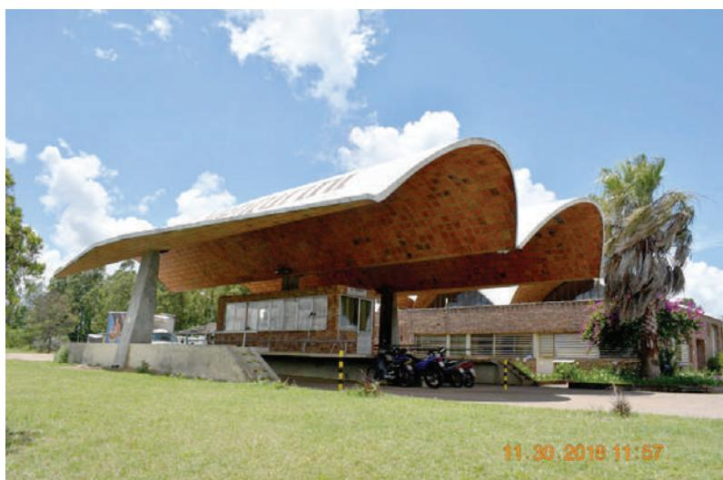
**Fig. I-74.** A solução estrutural poderia ser, em vez de 1 pilar, 2 pilares, mas arquitetonicamente o conjunto requeria a solução tomada. Construtivamente, a após-tensão em duplo balanço é muito mais fácil e segura de fazer. (\*-5).
