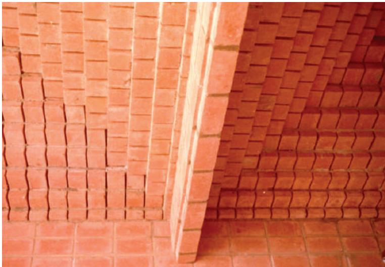
**Fig. XI-64.** Um cômodo ocupa dois espaços, uma viga de meio tijolo; suas armaduras estão na junta mais baixa da viga. Esses forros-pirâmides chegam direto na parede. (\*-5).
