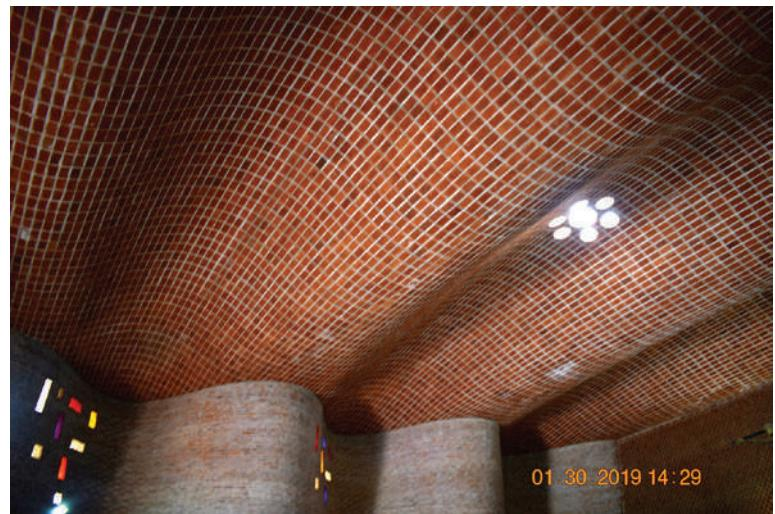
**Fig. XII-7.** Por meio da tecnologia de "paredes duplas de tijolo com armaduras guias", as paredes são muito resistentes e podem ser furadas para iluminação como quiser, o mesmo que a abóboda de dupla curvatura. A junção de ambas fazem um nó espacial estrutural rígido. (\*-5).
