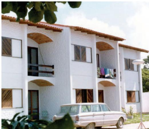
**Fig. V-40.** Somente se nota as abóbodas nas sacadas, mas no resto os forros e entre piso também são de abóbodas com tijolo à vista. (\*-5).
