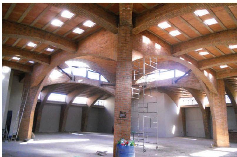
**Fig. VI-38.** Detalhe da iluminação zenital. (\*-5).
