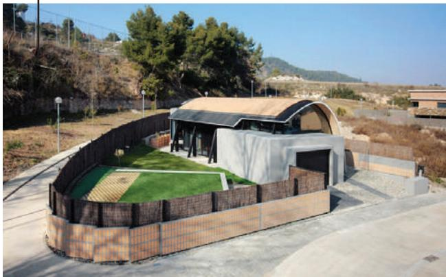
**Fig. X-56.** Vista externa da Casa Mingo onde foi usado o *Flexbrick* na cobertura e na cerca externa. (\*-16).
