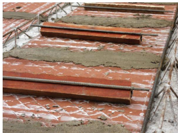
**Fig. VI-32.** Os sarrafos com molduras feitas com ferro de obra para dar reentrância nas juntas entre placas cerâmicas por baixo. (\*-5).
