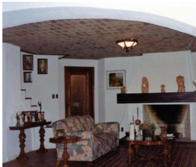
**Fig. V-52.** Tijolo armado em entrepiso, onde a abóboda virou laje horizontal. (\*-5).
