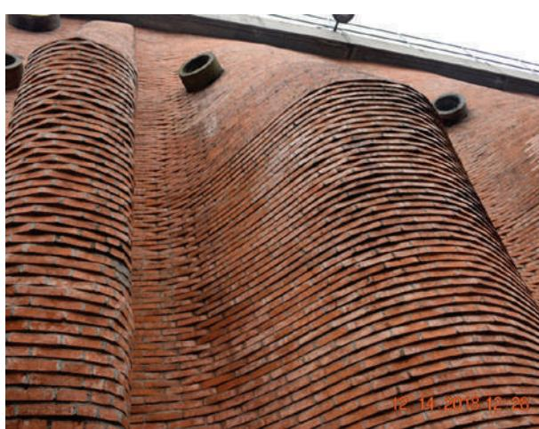
**Fig. XII-51.** Detalhe da fachada de dupla altura. A parede é sempre dupla com armaduras retas no meio. (\*-5).
