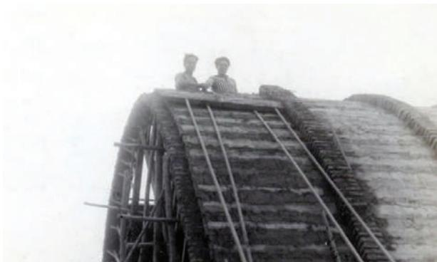
**Fig. IV-23.** Os pré-moldados da parte superior sobem-se com cordas, deslizam-se sobre as faixas-guias de madeira. Elevam-se em paralelo dos dois lados. (\*-5).
