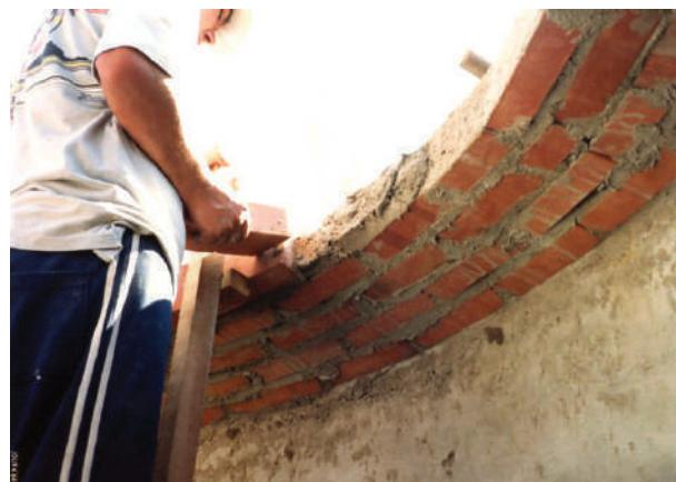
**Fig. VIII-14.** Neste caso, de acordo com as condições da argamassa, o pedreiro decidiu colocar mais argamassa para os próximos tijolos a fim de perder umidade. A limpeza das rebarbas das juntas se faz com colher, e o maior ou menor capricho depende de um detalhe: se a cúpula fica à vista ou não. (\*-5).
