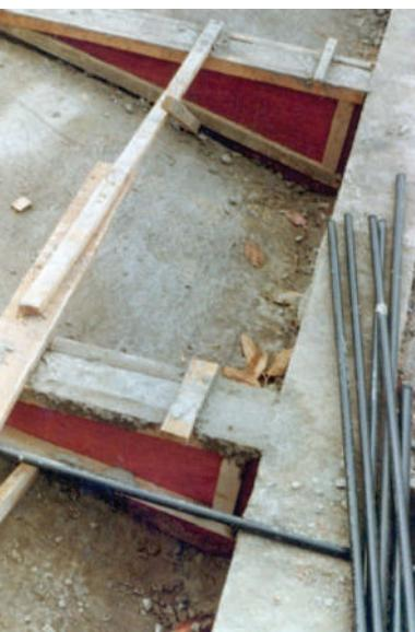
**Fig. V-37.** Formas padronizadas reaproveitáveis para as nervuras. (\*-5).
