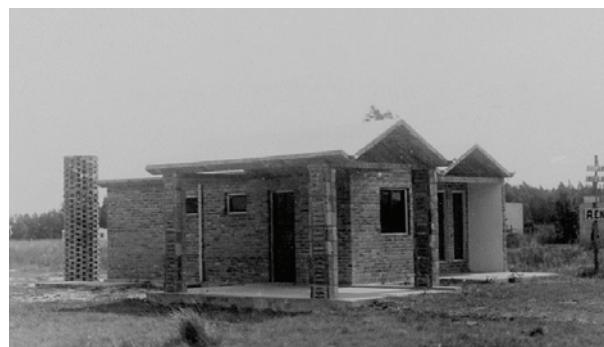
**Fig. XI-76.** As colunas são de tijolo armado, além da cobertura e da caixa d'água. (\*-5).
