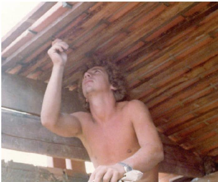
**Fig. V-31.** Limpando as juntas com o dispositivo da Fig. V-32. (\*-5).
