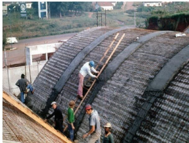
**Fig. III-86.** Neste caso, a corda é muito grande, (12 m.), é uma abóboda de simples curvatura e se faz previamente o enchimento dos arcos, reforços transversais. (\*-5).
