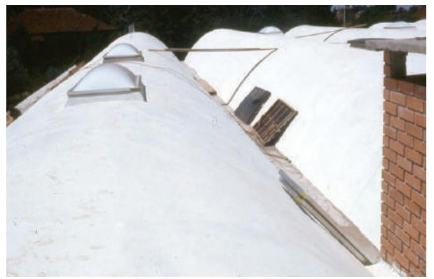
**2 Figs. III-91.** Cobertura pintada de branco com tinta emborrachada, impermeabilizante. (\*-5).
