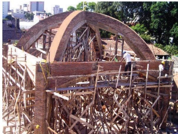
**Figs. VIII-50 e VIII-51.** Os arcos centrais prontos e as vigas-arcos-cintas em volta, em tijolo armado, em construção. (\*-5).
