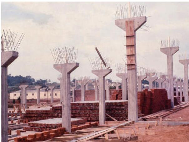
**Fig. III-45.** Estocagem sob a futura cobertura, repartido segundo as necessidades. (\*-5).
