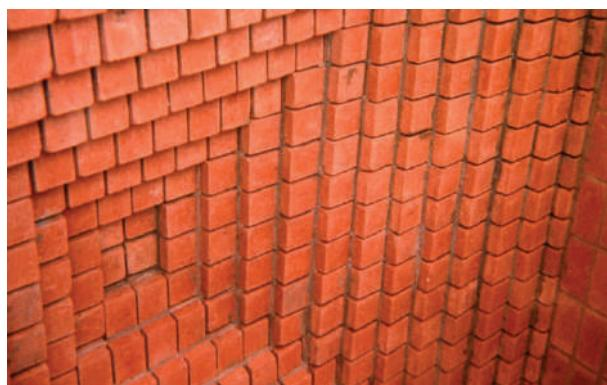
**Fig. XI-63.** Vista interior ao centro superior do cômodo, degraus com avanços de meio tijolo. (\*-5).
