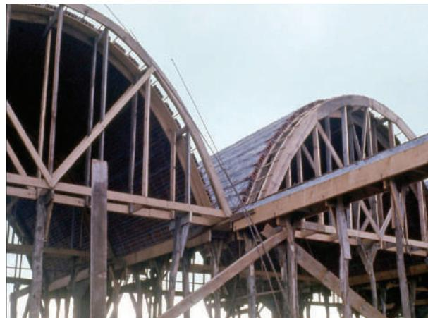
**2 Figs. III-73.** Avanço frontal com 2 cambotas por abóboda. Neste caso, as cambotas são chamadas “separadas”, o que permite colocar sobre elas, uma plaqueta tirada do tijolo especial usado, fazer um nervo transversal e avançar um plus a mais por dia. (\*-5).
