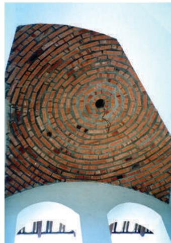
**Fig. VIII-15.** Forro cupuliforme no mirante do Sitio Sto. Antônio - o sistema construtivo desta cúpula é o mesmo da caixa d'água. (\*-5).
