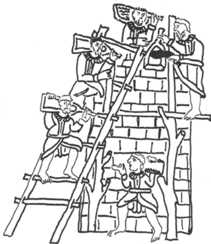
Construção no século XI – Andaimas armados com troncos e galhos de árvores
