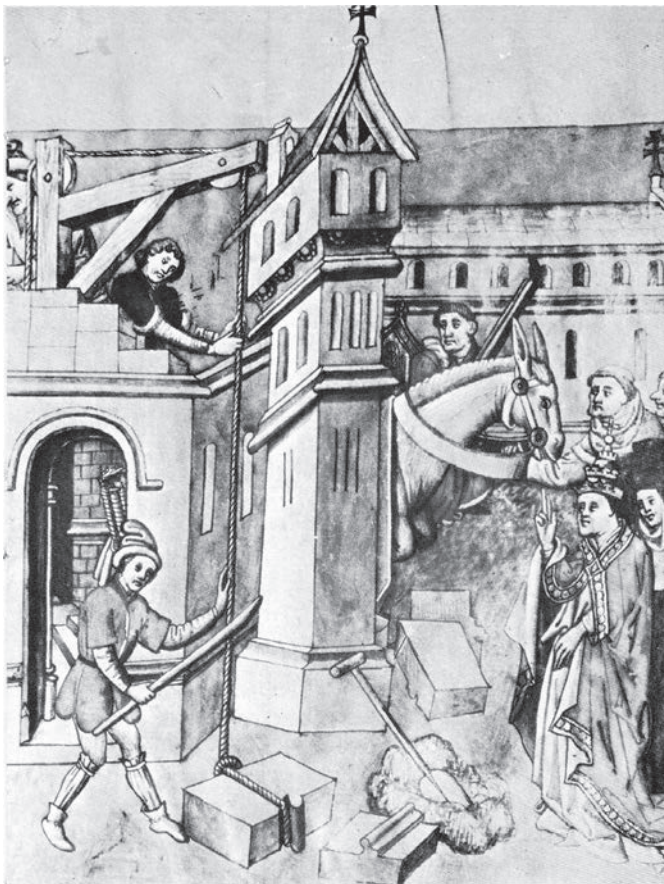
Engenho e método de suspensão de pedras pesadas, no século XV.
