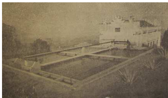
Figuras 60 e 61: antigos tanques de decantação e edificação da estação de tratamento em duas épocas. A primeira figura é o projeto original, e a segunda é a mesma estrutura adaptada e já com outra função em 2008. Fontes: Abreu (1953) e CORSAN (2008), respectivamente.
