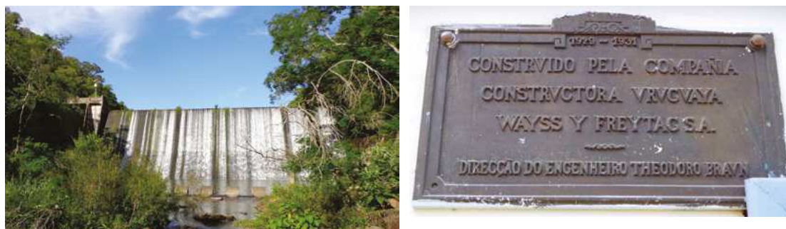
Figuras 70 e 71: a primeira figura é a barragem acumuladora no ano de 2012. Antes da enxurrada que houve em maio de 1984 (MAGNA, 1984), que destruiu parte dela, havia uma passagem por cima da queda d'água, ligando uma extremidade à outra, como nas duas figuras anteriores. A segunda figura é a placa em metal que estava fixada na barragem, identificando a empresa que a construiu, o engenheiro responsável pela obra e o período, de 1929 a 1931. Atualmente, a placa encontra-se fixada em uma parede dentro da edificação da antiga estação de tratamento. Fonte: fotos do autor em 2012.
