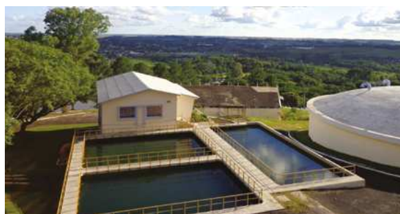
Figuras 62 e 63: estrutura da antiga estação de tratamento adaptada para tratar a água proveniente da lavagem dos filtros de areia do sistema de tratamento atual. Na segunda figura, os filtros de areia desativados da antiga estação já provenientes de outras adaptações. Fontes: fotos do autor em 2012.
