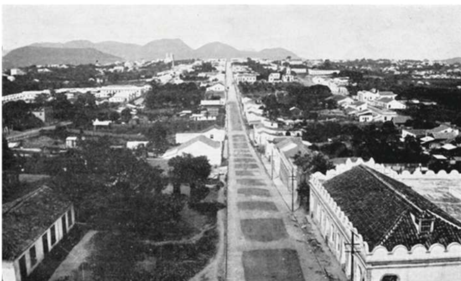
Figura 50: Rua do Comércio em fotografia tirada da edificação do 7º RI na Av. Borges de Medeiros em direção ao centro da cidade. A cada um ou mais terrenos, era feita uma faixa de calçamento atravessando a rua e unindo as sarjetas. No trecho da rua mais próximo do centro, ao fundo da imagem, a via já é toda calçada. Fonte: acervo da Casa de Memória Edmundo Cardoso.
