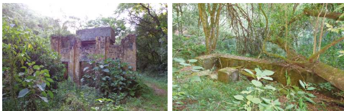
Figuras 74 e 75: a primeira figura é a antiga casa de máquinas em ruínas próxima à represa de tomada. Próximo a esta, na segunda figura, estão as ruínas da casa do zelador da barragem. Fonte: fotos do autor em 2012.
