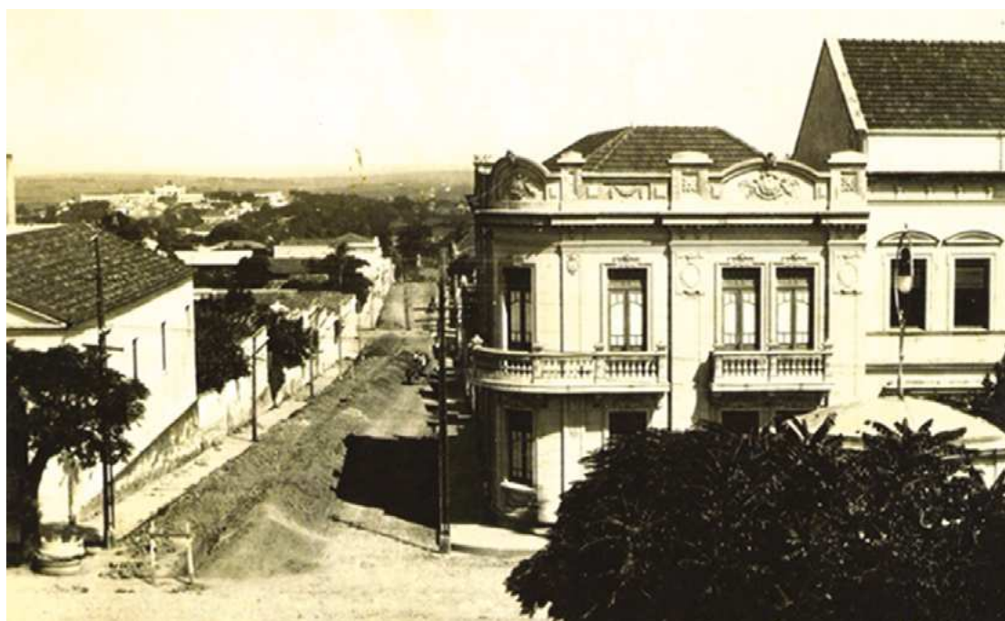
Figura 67: obras de saneamento na Rua dos Andradas, esquina com a Av. Rio Branco. Fonte: acervo Casa de Memória Edmundo Cardoso.
