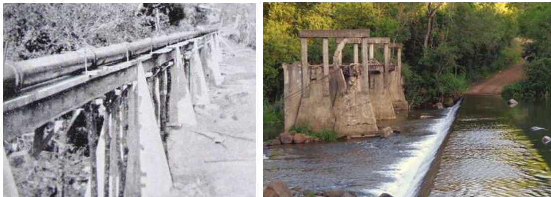
Figuras 76 e 77: “Passo do Macaco” com as adutoras. Na primeira figura, a adutora passa por cima do rio, no ponto A marcado na figura 52. Na segunda figura, mesma estrutura, em ruínas, já alterada para comportar duas adutoras que foram relocadas e envelopadas para junto do rio, servindo a estrutura em concreto também para passagem de veículos. Fontes: Intendência (1930) e foto do autor em 2012, respectivamente.
