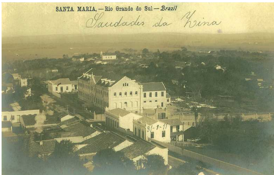
Figura 27: a fonte está aos fundos da edificação do Colégio Sant'Anna, na esquina das ruas Floriano Peixoto e Andradas. O local era utilizado para lavar roupas que, na imagem, estão estendidas no local para quarar. A fotografia foi tirada em 31/09/1911. Em 1870, a Câmara Municipal doou às Irmãs Franciscanas essa área, compreendida entre as ruas Floriano Peixoto, Silva Jardim, Serafim Valandro e Andradas, que configurava a Praça Três de Maio, para construção do colégio (MORALES, 2008). Fonte: acervo da Casa de Memória Edmundo Cardoso.
