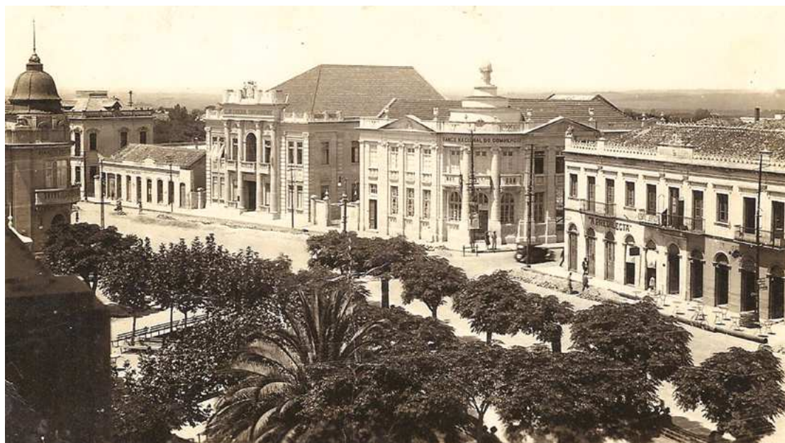
Figura 66: obras de saneamento na Rua do Acampamento, esquina com a Rua do Comércio, em 1930. “Estão sendo descarregados na Rua do Acampamento os tubos que serão ali utilizados na rede de água, prosseguindo as escavações no centro da cidade” (DIÁRIO DO INTERIOR, 19/dez/1929). Até 31 de dezembro de 1929, na Rua do Acampamento, entre as ruas José Bonifácio e do Comercio, já tinham sido colocados 532 metros de canos para abastecimento d’água (INTENDÊNCIA, 1930). A cúpula, à esquerda, é do antigo edifício do Banco Pelotense, e o palacete, que aparece em parte, atrás, era a residência do Dr. Astrogildo de Azevedo. A edificação de esquina, quase ao centro da foto, é o Banco Nacional do Comércio, com um atlas no coroaamento. Fonte: acervo da Casa de Memória Edmundo Cardoso.
