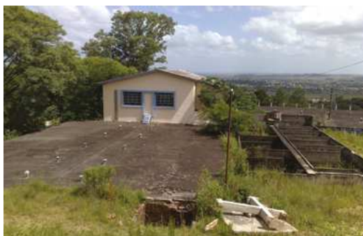
Figuras 60 e 61: antigos tanques de decantação e edificação da estação de tratamento em duas épocas. A primeira figura é o projeto original, e a segunda é a mesma estrutura adaptada e já com outra função em 2008. Fontes: Abreu (1953) e CORSAN (2008), respectivamente.
