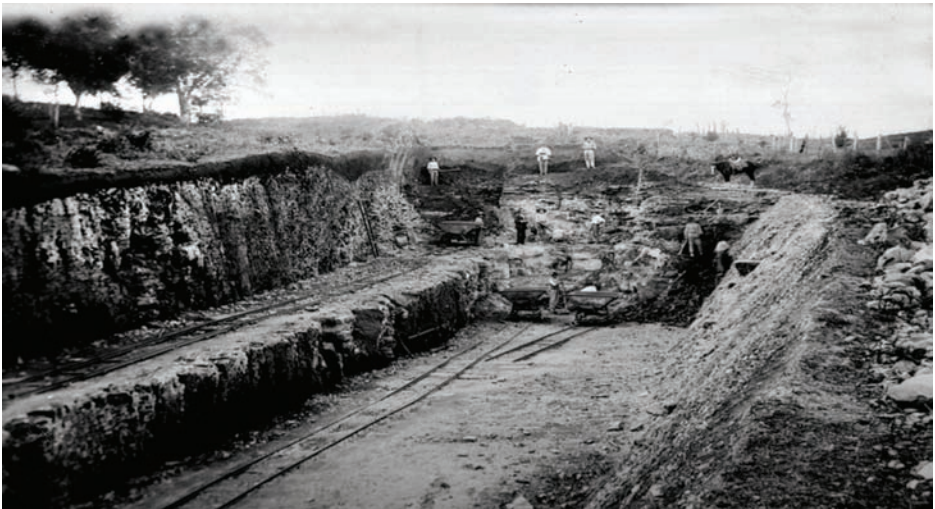
Figura 58 - Construção da estrada de ferro em Bento Gonçalves (1918).
