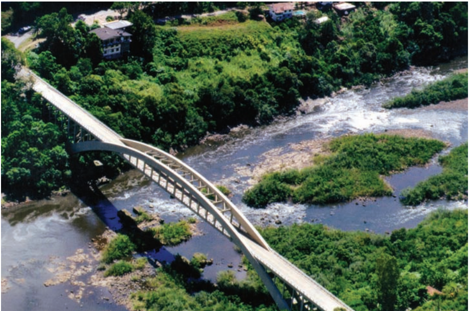
Figura 68 - Ponte sobre o Rio das Antas.
