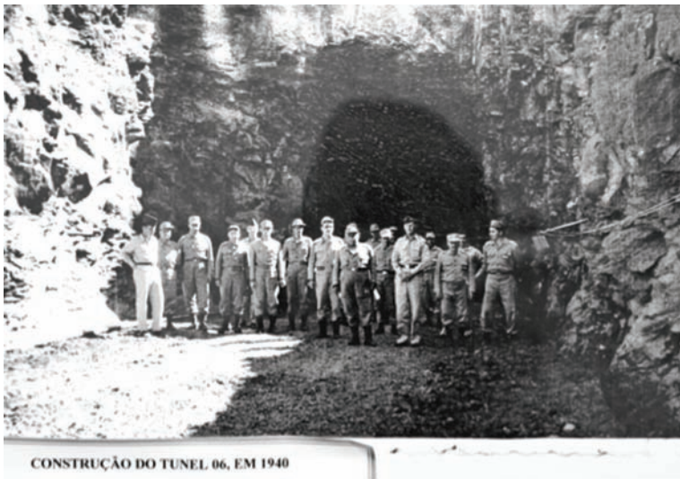
Figura 59 - Construção da estrada de ferro e dos túneis pelo batalhão ferroviário de Bento Gonçalves.
