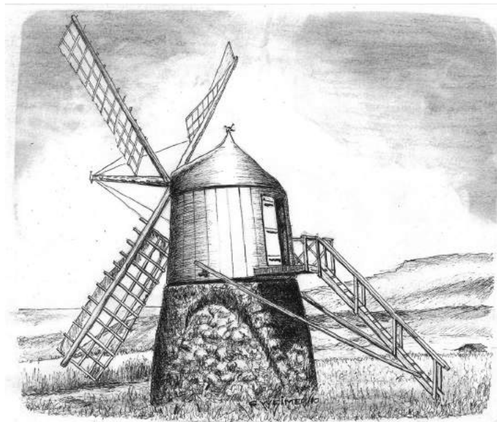
Figura 34 – Desenho de um moinho de vento por nós fotografado na Ilha do Faial, em fevereiro de 1999. A escada serve, ao mesmo tempo, para dar acesso ao moinho e de alavanca para girar o engenho.
